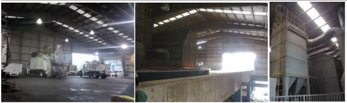
Figura 36: Área de maniobras, puente de desaceleración y techumbre
