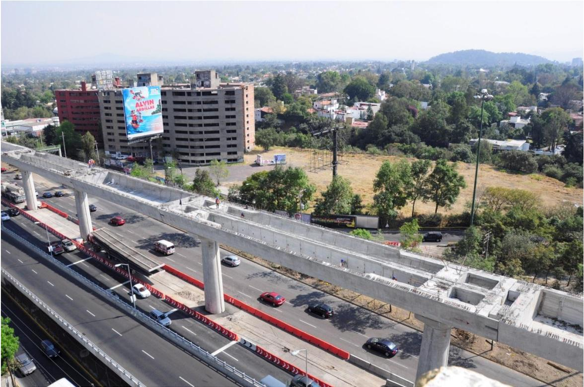
**Ilustración 21. Diferentes tipos de traves.**
