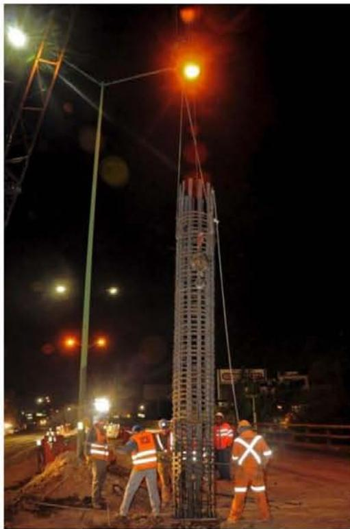
**Ilustración 17. Proceso para realizar pilas.**
