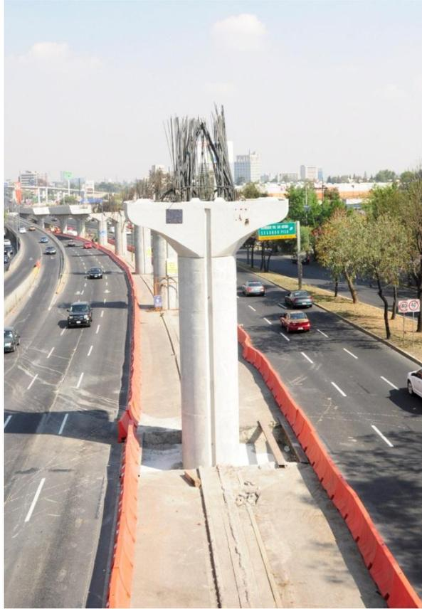
**Ilustración 20. Columna y cabezal.**
