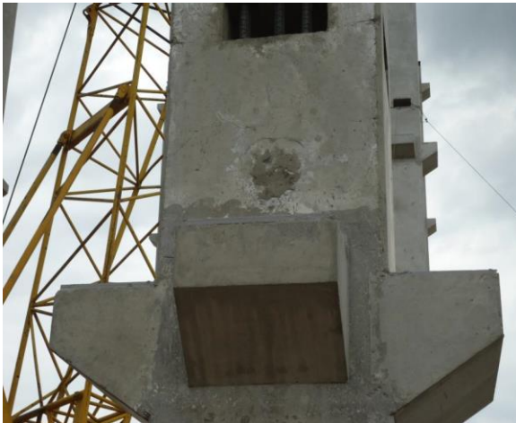
Figura 2.13. Columnas con ménsulas de concreto. Las traveses se apoyan directamente en la ménsula de la columna y posteriormente se realiza la unión entre accesorios metálicos con soldadura estructural. Proyecto: centro comercial Coacalco.
