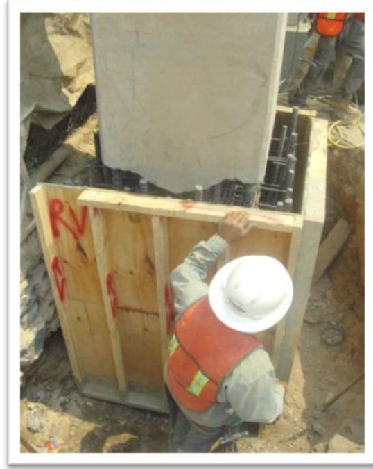
Figura 4.48. Trabajos de cimbrado en dado de conexión pila-columna.
