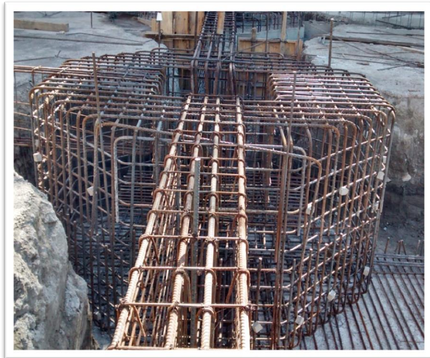
Figura 2.2. Adecuación en contratrabes para fabricación de candelero. Proyecto: centro comercial pabellón Azcapotzalco.
