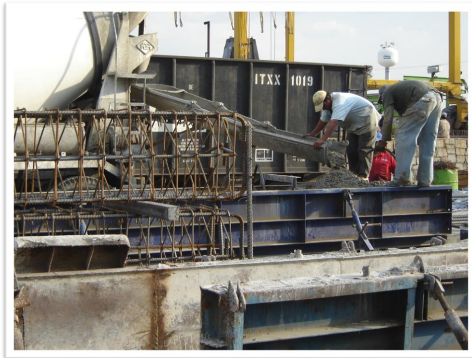
Figura 4.14. El colado de las trabes se realiza con concreto de resistencia rápida, en este caso con un 80% de su resistencia nominal a las 14 horas con el fin de poder destensar al día siguiente y habilitar la siguiente línea de colado.
