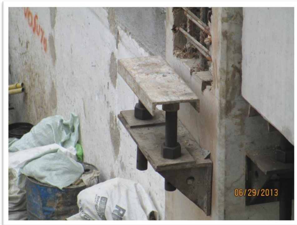
Figura 4.40. Previo al montaje de las traves se deben colocar y nivelar las ménsulas metálicas temporales.
