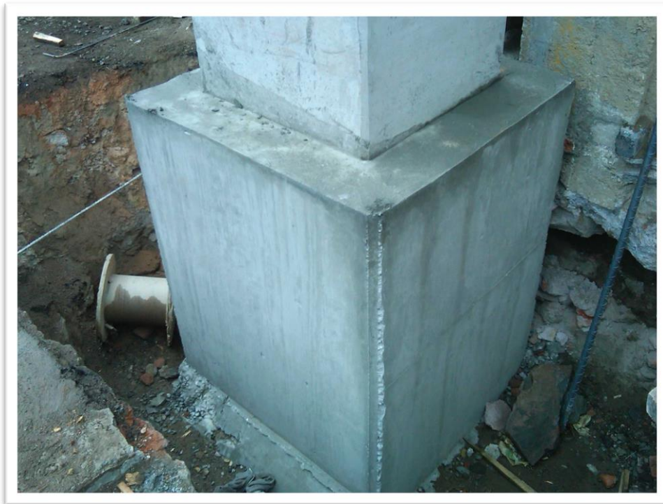
Figura 4.39. Una vez alineada la columna verticalmente se procede al colado de su conexión con la cimentación.
