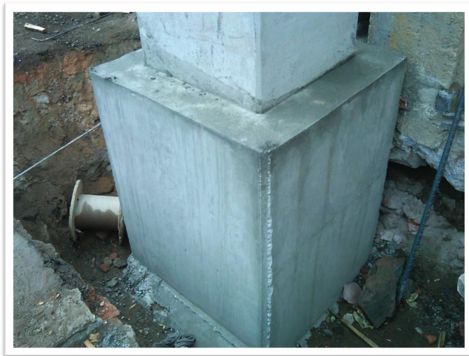
Figura 4.49. El dado de conexión se cuela con concreto de resistencia rápida (80 % de la resistencia nominal a 72 horas), por lo que una vez colado el nodo la grúa de carga puede soltar la columna al día siguiente de haber sido montada.
