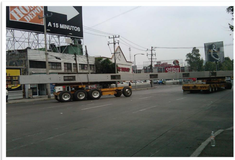
Figura 4.25. Maniobras de entrada por avenida Patriotismo de la columna prefabricada en el predio en el que será montada en su posición final.
