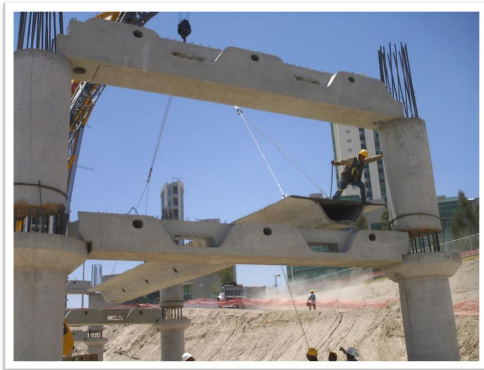
Fig. 2.37. En esta imagen se observan las trabes tipo TPOM y el montaje de losa tipo Omega.
