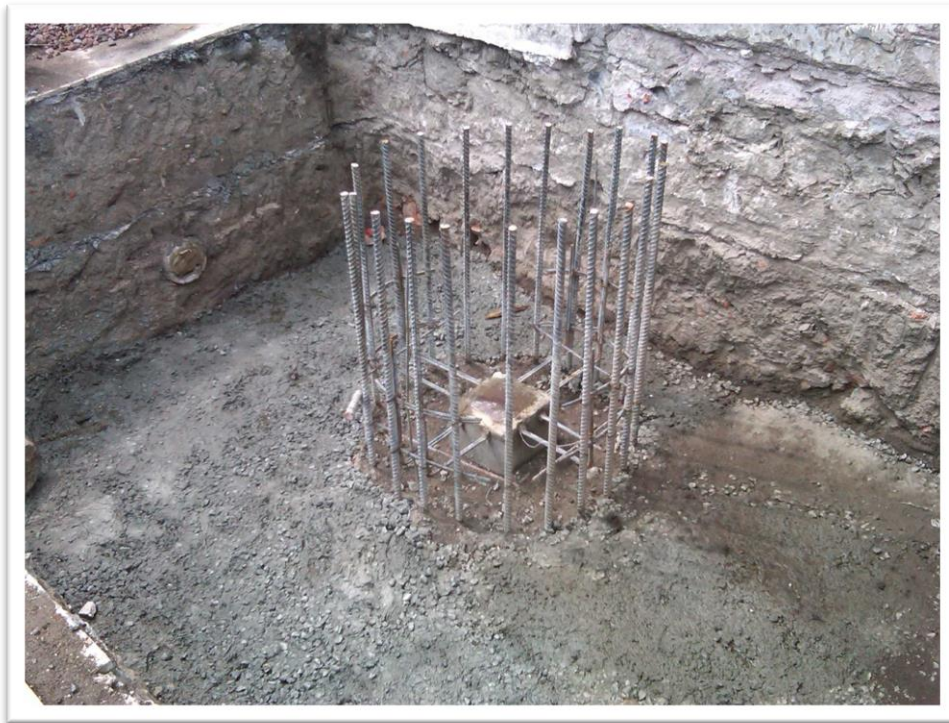
Figura 4.33. Imagen que nos muestra la preparación que se deja en la pila de cimentación (placa niveladora) para el montaje y alineación de columna prefabricada.
