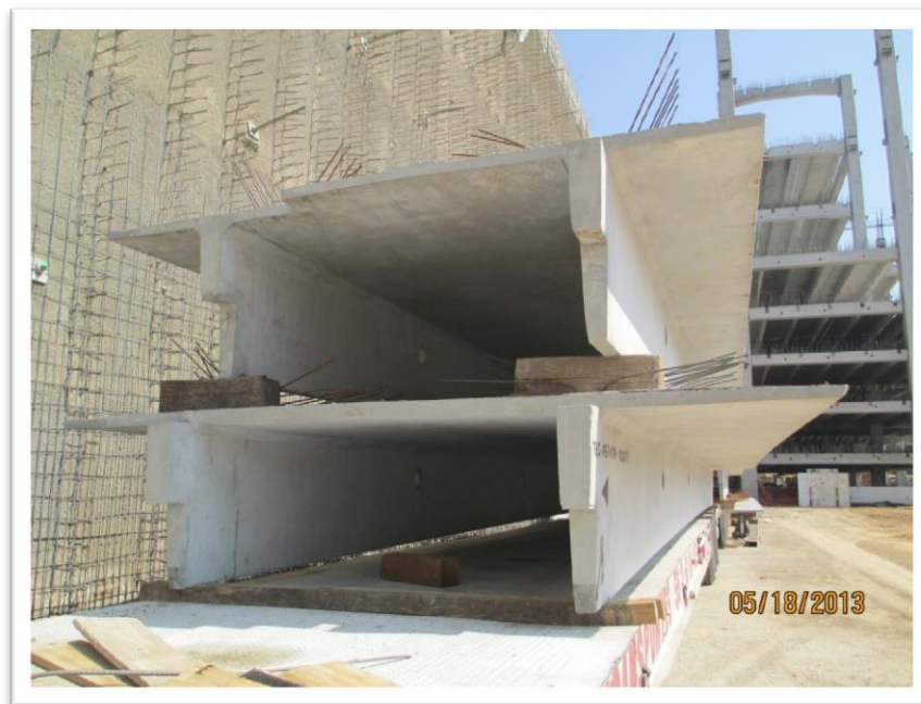
Figura 2.16. Como se observa en esta imagen, las losas TT pueden cubrir claros de hasta 20 m. Proyecto: parque el Toreo, claro de 16.00 m.
