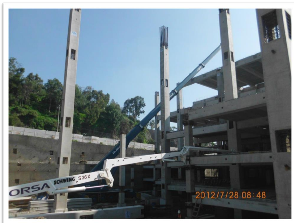
Figura 2.10. Columnas con nodo abierto. Las trabes se apoyan en la columna mediante ménsulas metálicas reutilizables. Proyecto: centro comercial patio Santa Fe.
