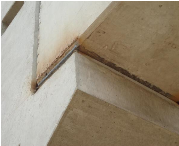
Figura 2.13. Columnas con ménsulas de concreto. Las traveses se apoyan directamente en la ménsula de la columna y posteriormente se realiza la unión entre accesorios metálicos con soldadura estructural. Proyecto: centro comercial Coacalco.
