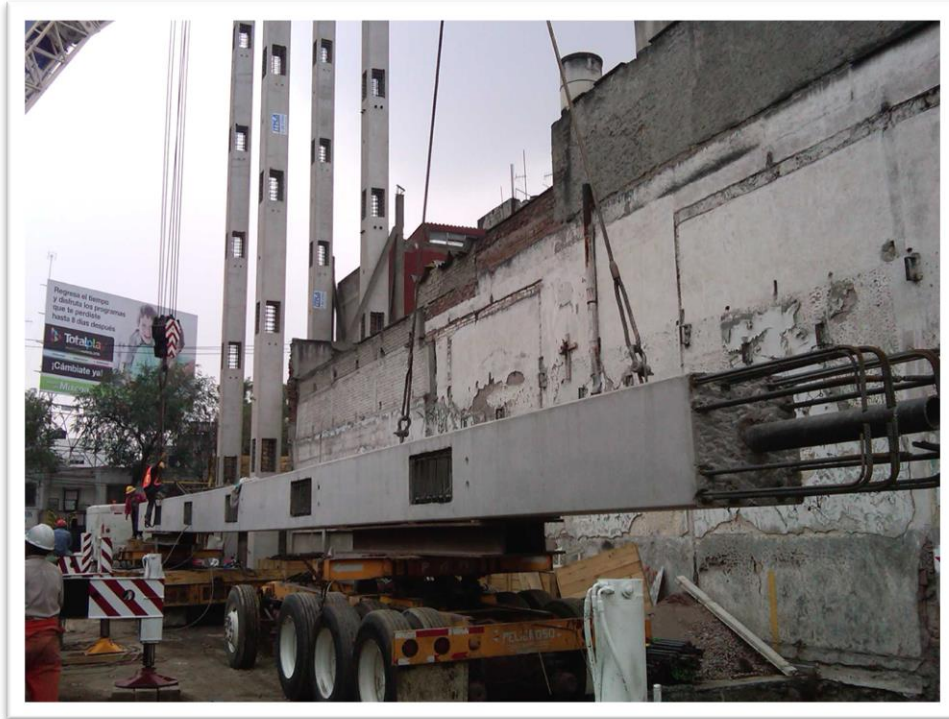
Figura 4.34. En esta imagen observamos las maniobras de izaje de las columnas de 28.60 m de longitud con sección de 80 x 80 cm.
