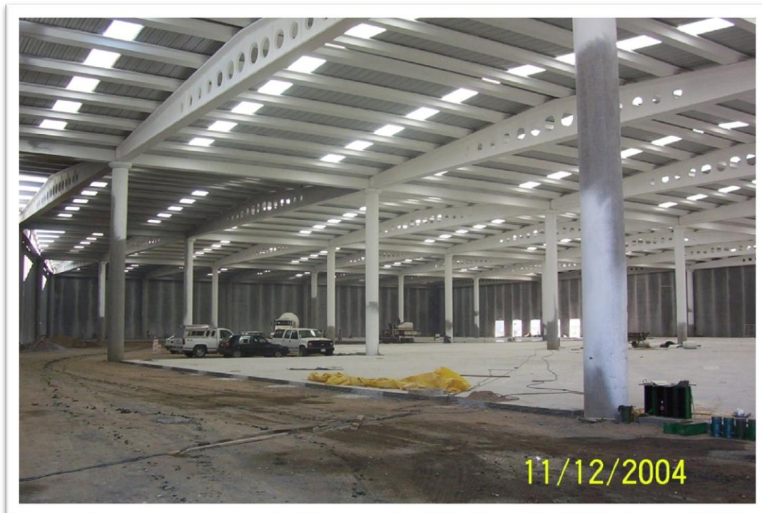
Figura 2.28. Nave industrial “Lerma” en el Estado de México, vista interior de la nave con cubierta ligera ya instalada.
