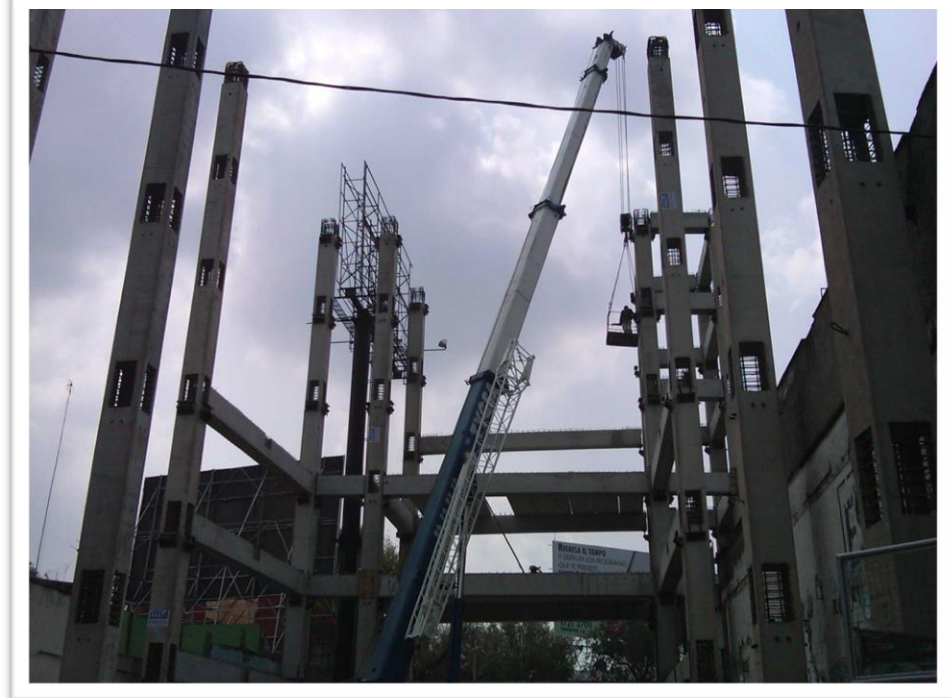
Figura 4.42. En esta imagen se observan la conformación de los marcos una vez montadas las traves prefabricadas.
