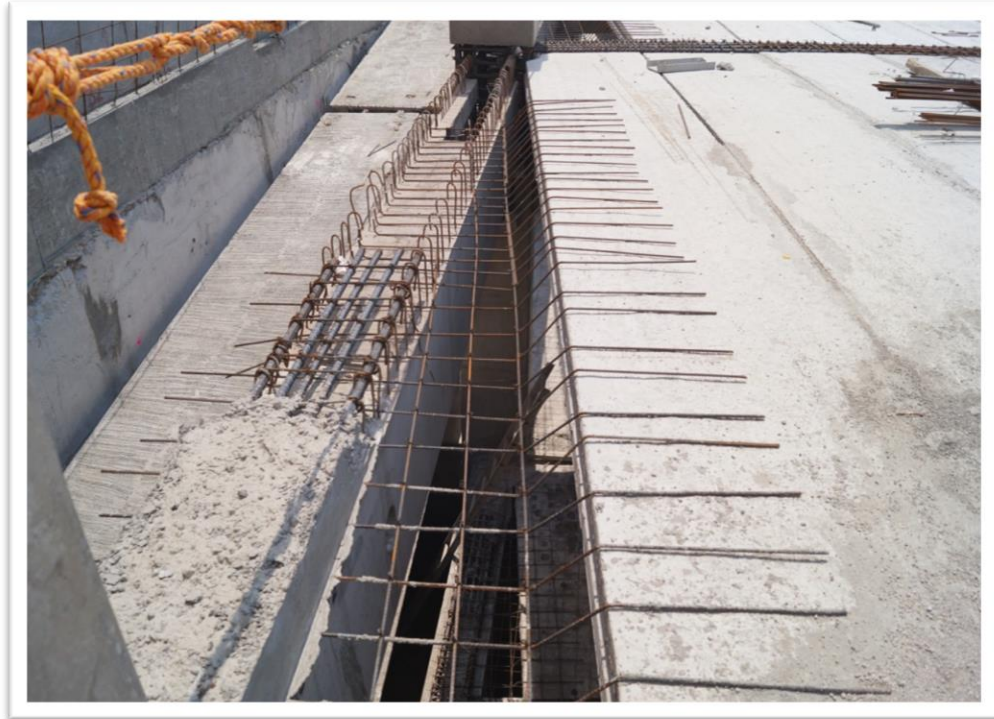
Figura 4.63. En esta imagen se observan los trabajos de armado del acero de refuerzo en las zonas que por su geometría no se alcanzan a cubrir con losa alveolar (colados de ajuste).
