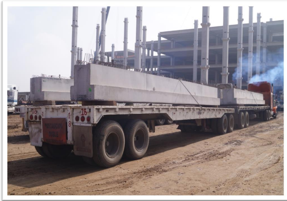
Figura 2.20. En la imagen se puede observar a la izquierda la geometría de la trabe portante de sección tipo TPL y a la derecha la trabe de sección tipo TPI esperando ser desembarcadas durante la construcción del proyecto centro comercial Cosmopol Coacalco.
