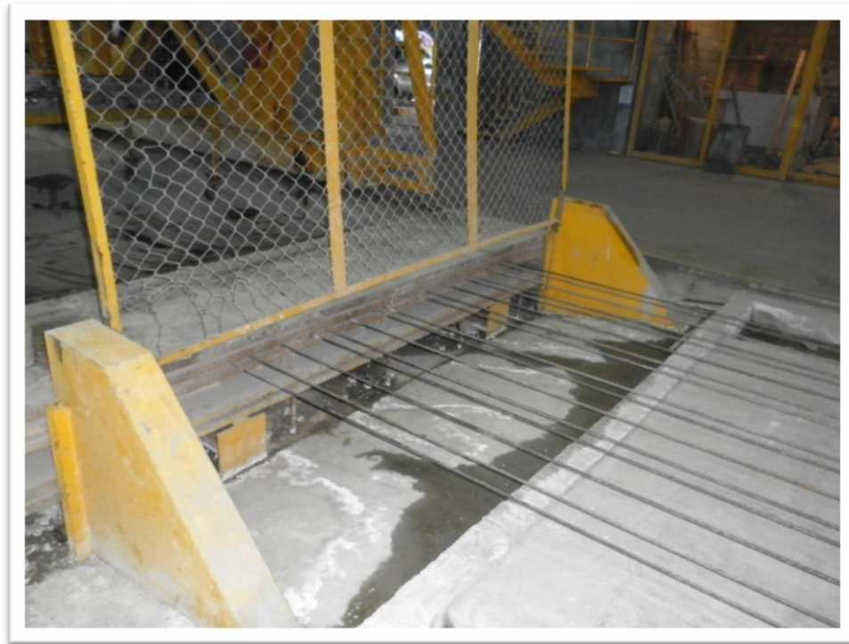
Figura 4.15. Las líneas de colado de losas alveolares están habilitadas exprofeso para esta actividad, la primera actividad para el colado de la línea es la colocación y tensado de los cables de presfuerzo a todo lo largo de la línea.
