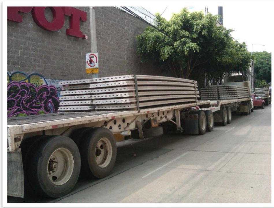
Figura 4.27. Transporte de losas alveolares en carga tipo full (2 plataformas regulares 2.40m x 12.00 m). Proyecto: Taller Soni Revolución.
