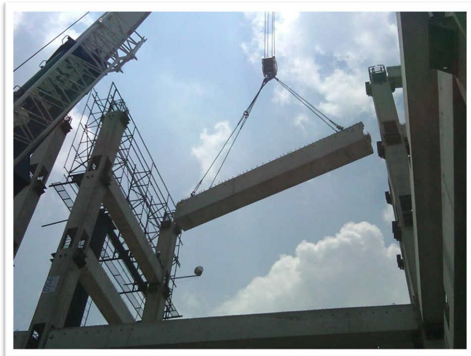
Figura 4.41. En esta imagen observamos los trabajos de izaje y alineación de las traves (portantes y rigidez) en las ménsulas metálicas.
