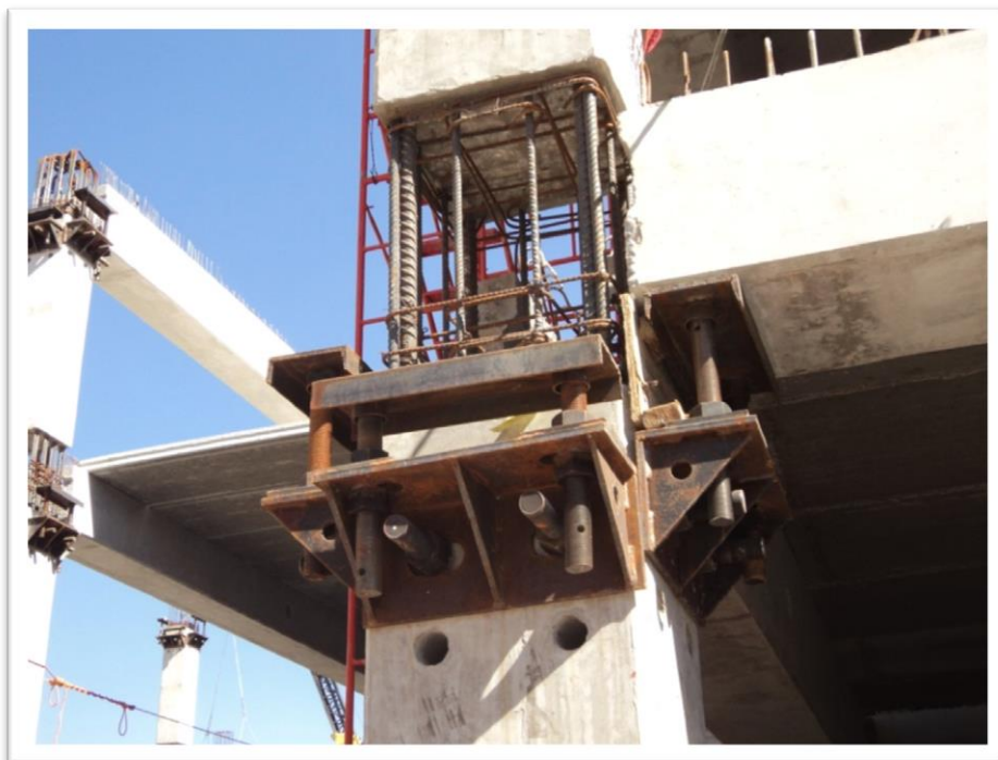
Figura 2.12. Ménsula metálica temporal, es ajustable y reutilizable, se puede retirar una vez que el colado del nodo ha alcanzado la resistencia de proyecto.
