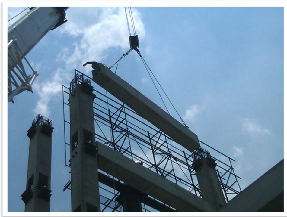
Figura 4.42. En esta imagen se observan la conformación de los marcos una vez montadas las traves prefabricadas.
