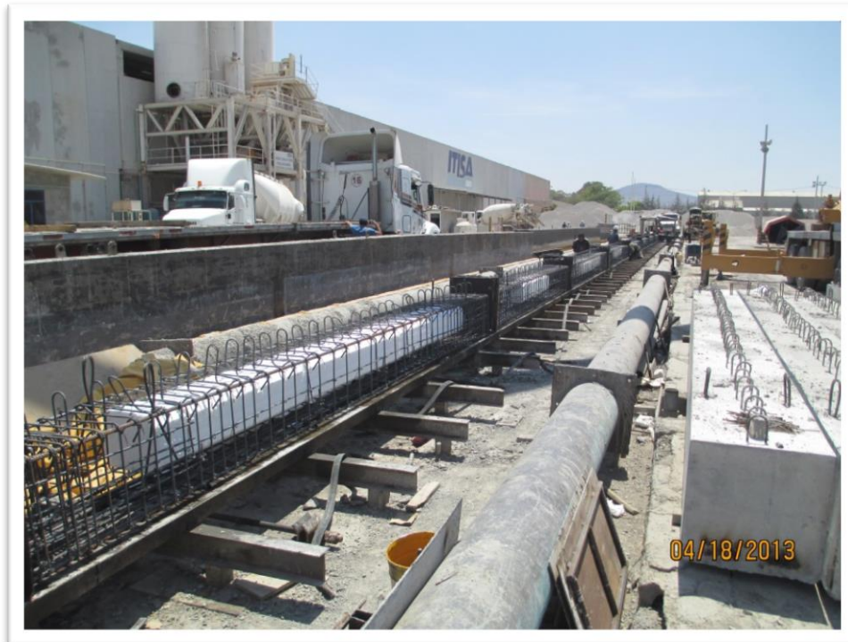
Figura 4.10. Como la línea es de 120 m de longitud se pueden colocar tantos armados como quepan en ella, siempre y cuando tengan la misma sección y número de torones.
