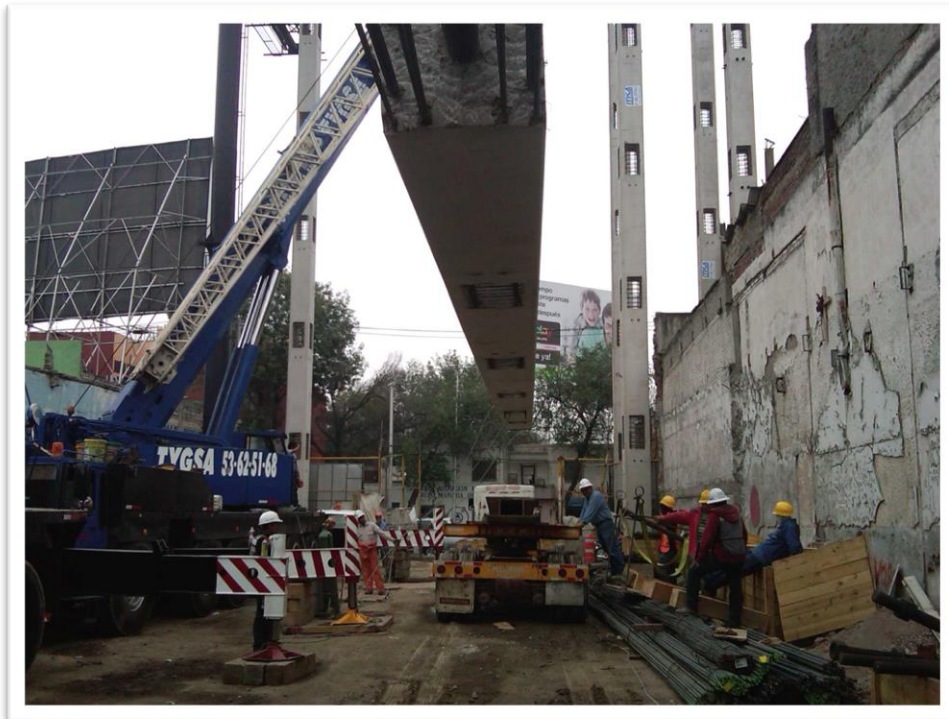
Figura 4.35. Una vez izada la columna es recomendable retirar el equipo de transporte para poder bajar la columna a piso e insertar el perno de izaje en la cabeza de la misma.
