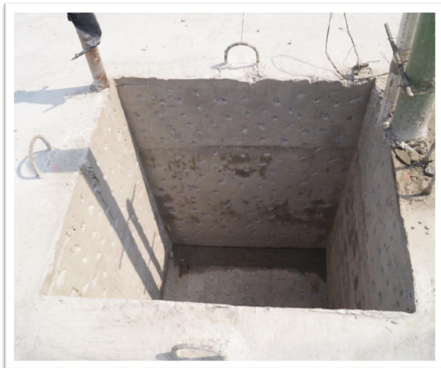
Figura 2.3. Vista de candelero terminado listo para recibir columna, nótese el escarificado en las paredes.
