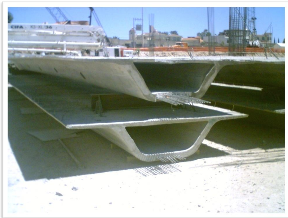
Figura 2.36. Imagen de losa Omega estibada de 18.00 m de longitud. Proyecto centro comercial Andares (Guadalajara, Jal.)
