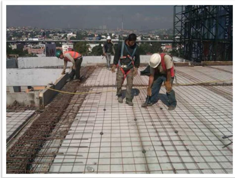
Figura 4.65. Durante la colocación de la malla electrosoldada se calza con silletas plásticas para ubicarla en el lecho donde se necesita el refuerzo.
