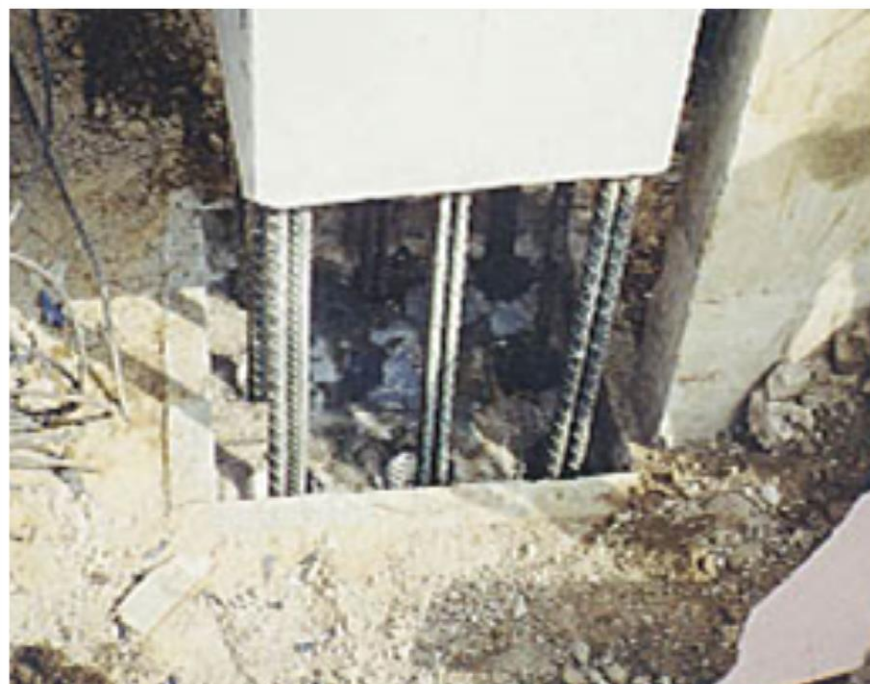
Figura 2.9. Montaje de columna insertando armado en ductos de cimentación. Proyecto: nave electrólisis Peñoles.
