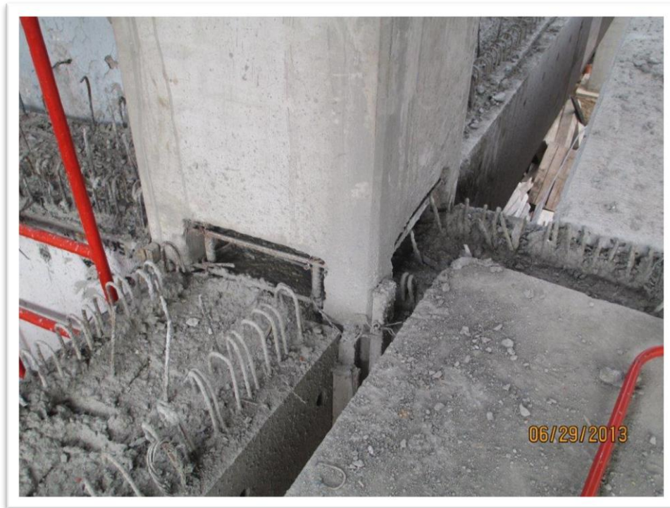
Figura 4.58. En esta imagen se observa el “nudo” ya colado, los huecos que se observan se cuelean en una segunda etapa junto con el firme de compresión.
