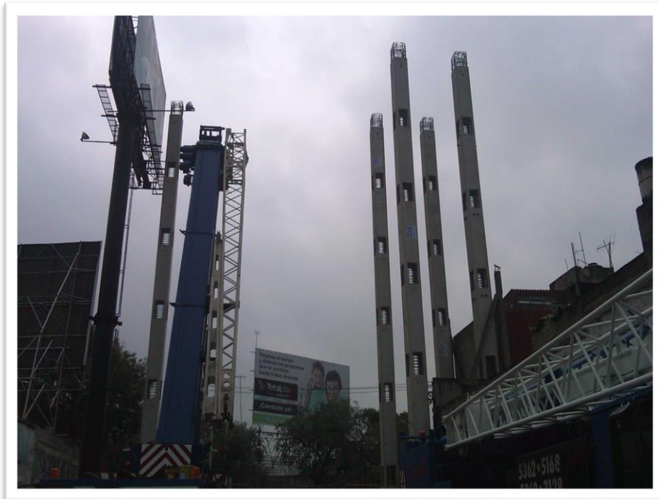
Figura 4.38. Para el caso de esta estructura se decidió que se montarían primero la totalidad de las columnas (14 piezas) para resolver el tema del poco espacio con que se contaba para su montaje.
