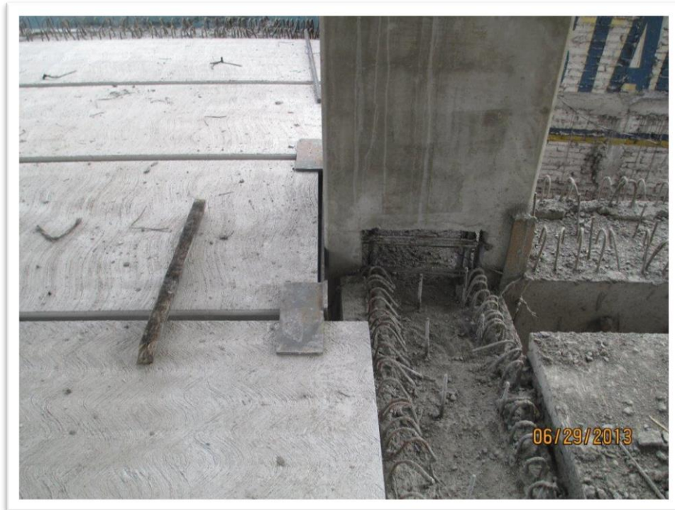
Figura 4.57. Adicionalmente por el hueco que se observa en la columna pasan las barras de acero de refuerzo de continuidad superior trabe-columna.
