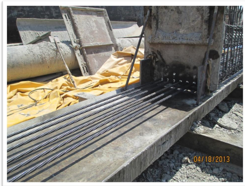
Figura 4.11. Una vez colocados los armados en la línea se procede a colocar los cables de presfuerzo o “torones” y las tapas de cada trabe en la longitud de la línea.
