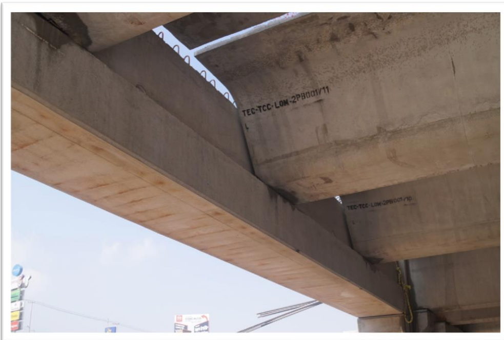
Figura 2.21. En la imagen se observa una trabe portante tipo TPL ya montada y “portando” las losas Omega para las cuales fue diseñada. Proyecto: centro comercial Cosmopol Coacalco.
