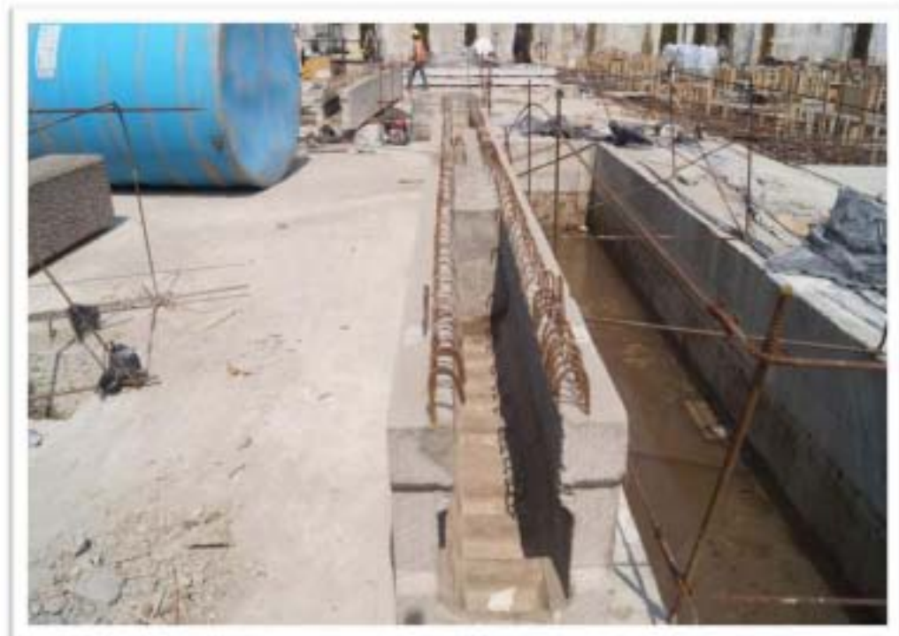
Figuras 2.51 y 2.52. En la imagen se observan travesaños tipo TPU del proyecto centro comercial Pabellón Azcapotzalco, Ciudad de México (2014).
