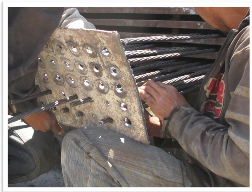
Figura 4.8. La "matriz" es una placa o placas que se adecua con la configuración o posición que los torones (acero de presfuerzo) ocuparán en la trabe, esta placa también sirve para anclar los "chucks" o conos que no permiten el regreso de los torones una vez que han sido tensados.
