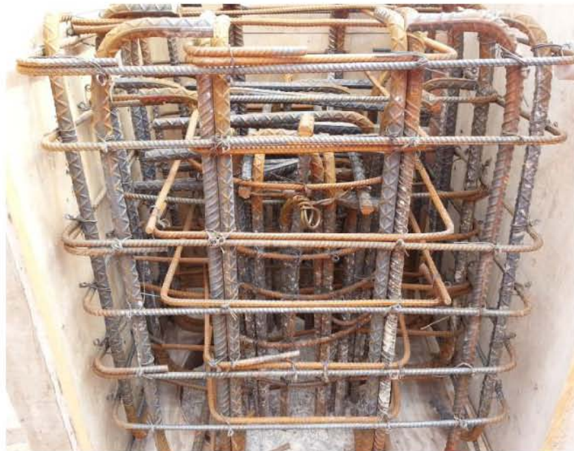
Figura 4.13 Armado de acero para cabezal y dado de concreto.
