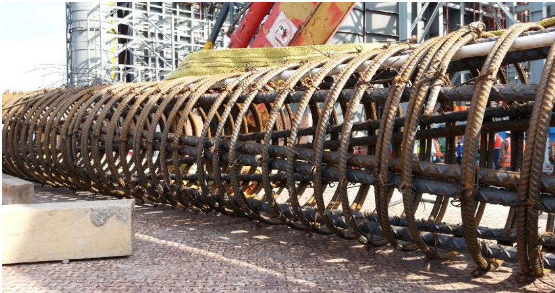
Figura 4.11 Armado de acero para la pila.
