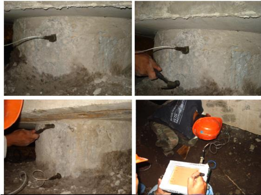
Figura 5.22 Ejecución de la prueba de integridad.
