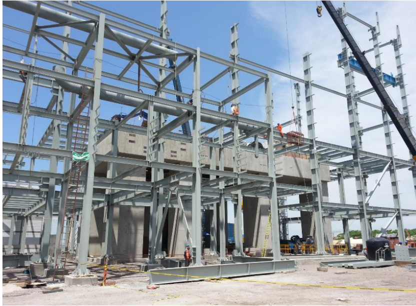
Figura 2.21 Montaje longitudinal 1 de la estructura de la casa de máquinas.
