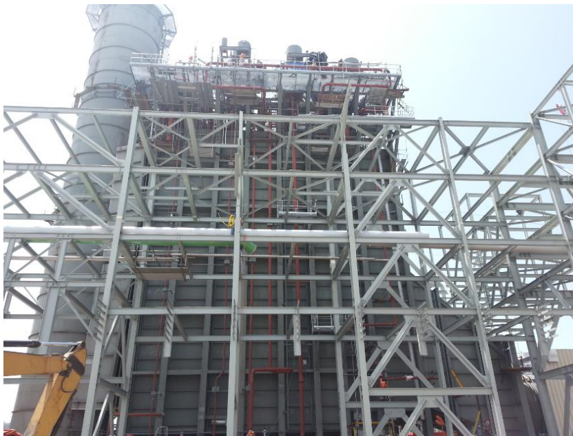
Figura 2.22 Montaje longitudinal 2 de la estructura de la casa de máquinas.
