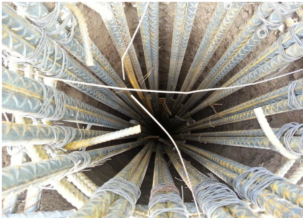
Figura 5.11 Colocación de refuerzo de pila de reacción.
