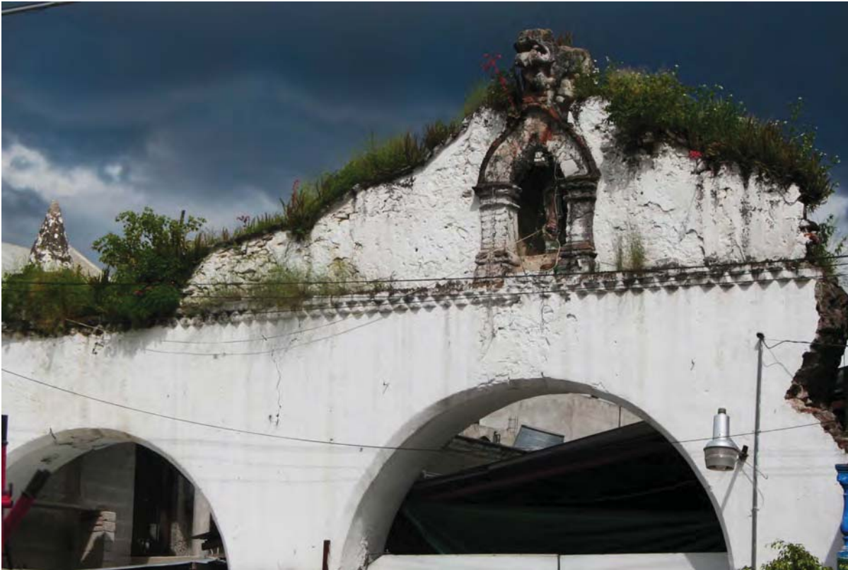
Fig. 5.1.9. Huellas de pintura mural reflejando barandal. Fotografía: Frida GES.
