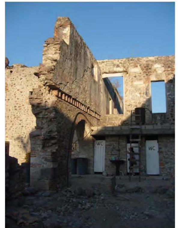
Fig. 5.0.1. Servicios sanitarios en ex convento. Fotografía: Frida GES
