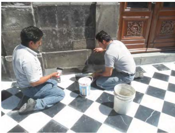
Fig.7.1.1. Ejemplo de retiro de flora nociva en elementos de cantera. Museo Nacional de Historia. Fotografía: Fernando López.
