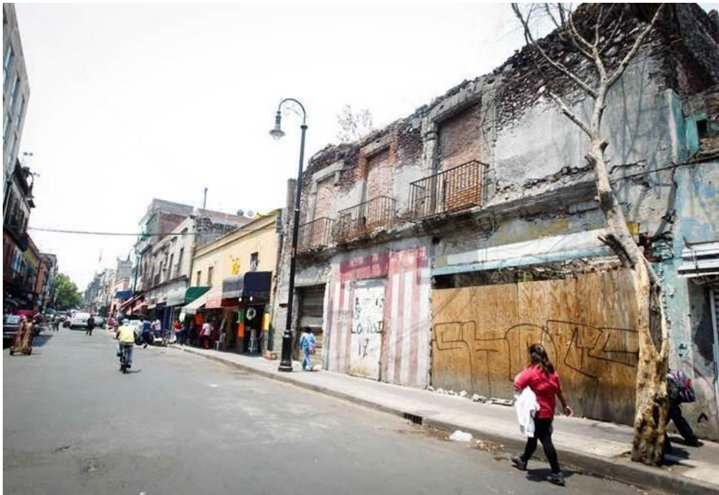
Ilustración 3. Las calles del norte y oriente del Centro Histórico (correspondientes al denominado Perímetro B) no han sido intervenidas de la misma forma que las calles que conforman el Perímetro A. Se pueden encontrar edificios en mal estado, falta de regulación del comercio informal y problemas en los servicios públicos. Es interesante notar que las zonas sin atender del Centro Histórico colindan con colonias y barrios considerados conflictivos, como La Merced y Tepito.
