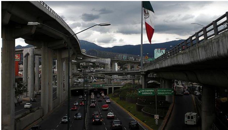
Ilustración 9. El anillo periférico, construido durante la década de los cincuenta, ha sido modificado —mediante la construcción de segundos pisos— para poder lidiar con el creciente número de automóviles que diariamente circulan por la ciudad.
