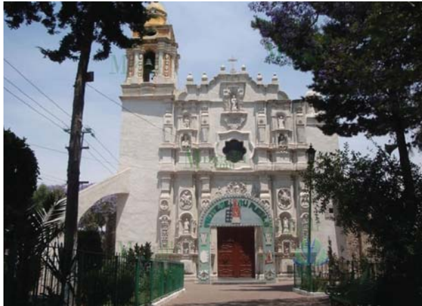
Templo de San Lorenzo Río Tenco.-El Templo, se encuentra en restauración por parte de CONACULTA, el INAH y la Comunidad.
