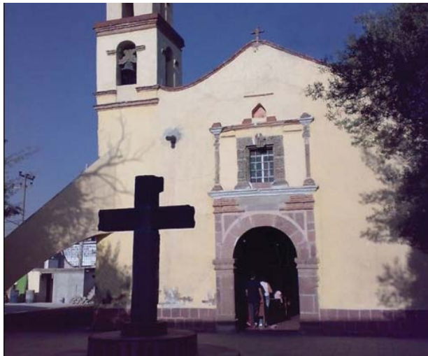
Templo de Santiago Tepalcapa.-Templo de Santiago Tepalcapa.- Refleja un estilo sobrio y austero y cuenta con contrafuertes grandes propios de la zona, su fachada casi no tiene adornos exteriores.
