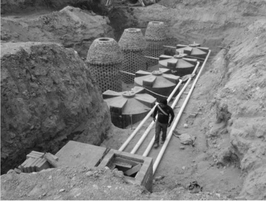
3. Construcción de infraestructura (en este caso de sistema de drenaje).
