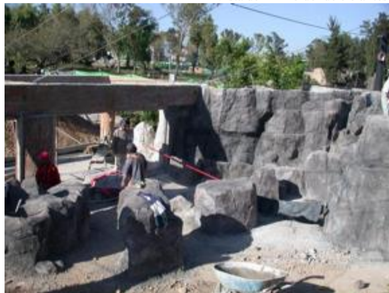
Construcción de hábitat de roca falsa para jaguar
