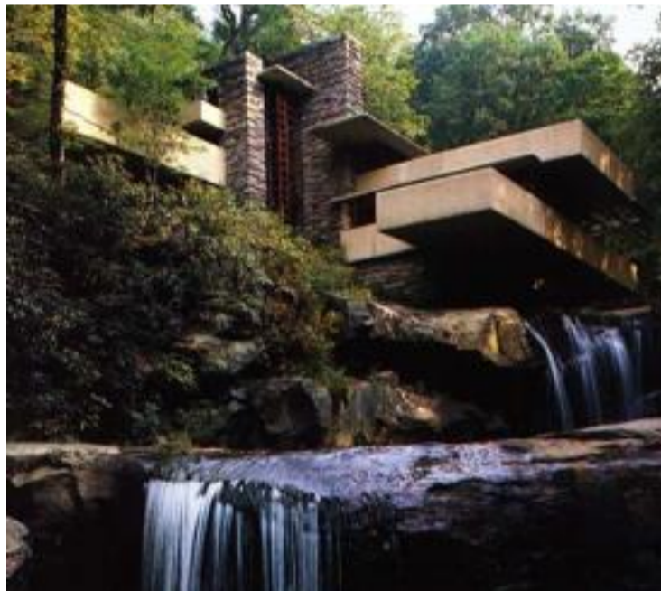
Casa de la Cascada
