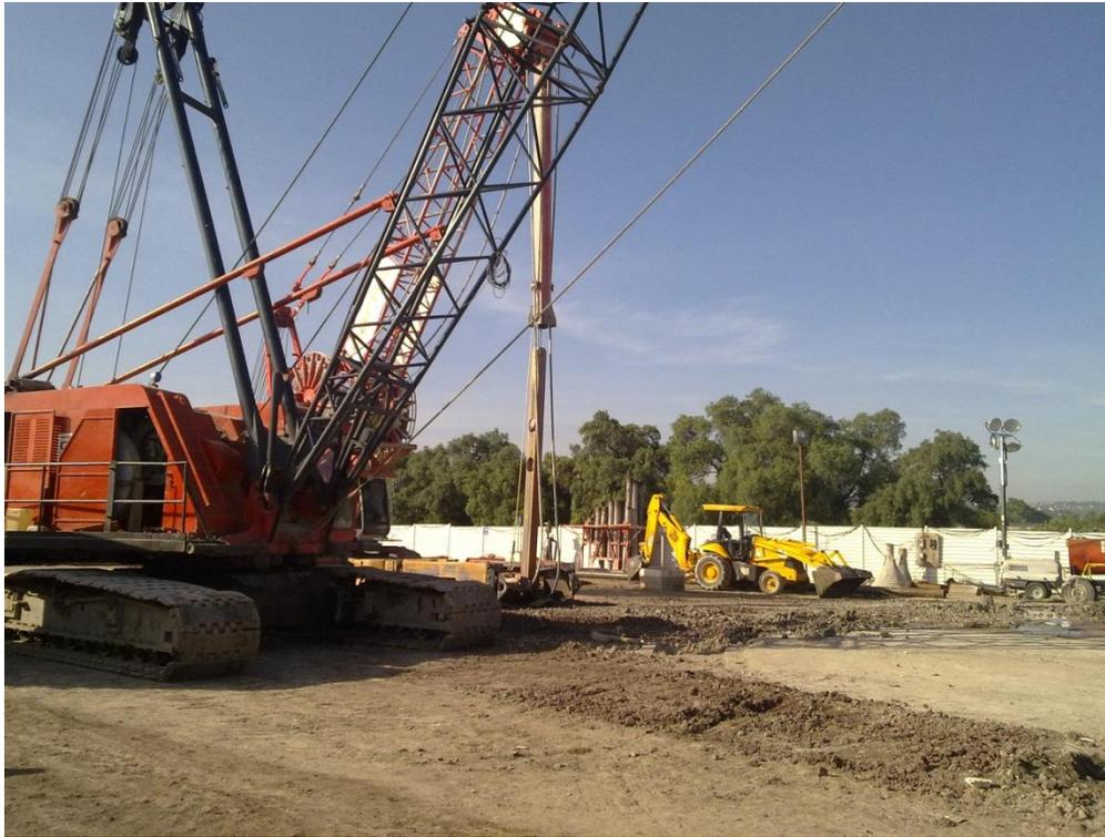
Foto No.4 Grúa para insertar tubería Tremie
