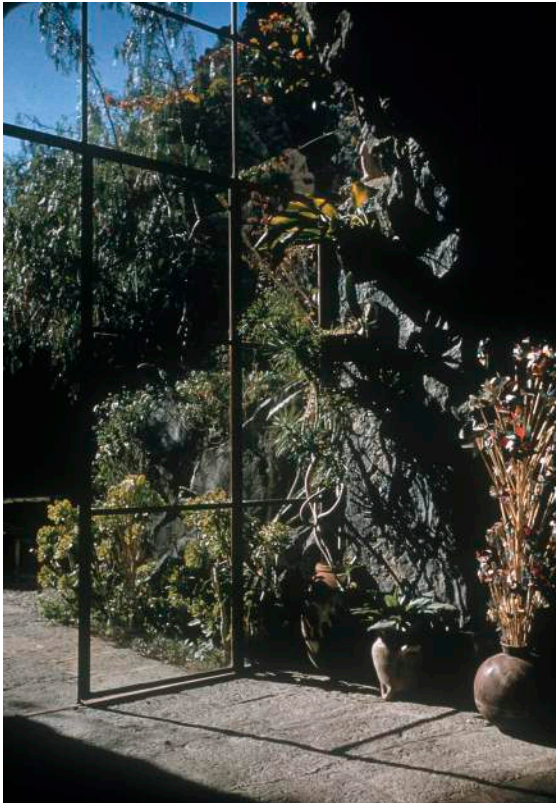
Fig. 2. Detalle entre el interior y exterior Además del tragaluz, otros elementos como las entradas mismas no se interpusieron como barrera entre la casa y su medio. El ventanal de piso a techo adaptado a la roca volcánica es lo único que divide ese espacio interno con el externo.
