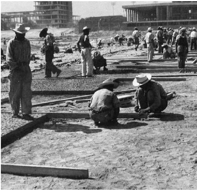
Fig. 33. Construcción de los paneles de mosaicos para la Biblioteca Central.
