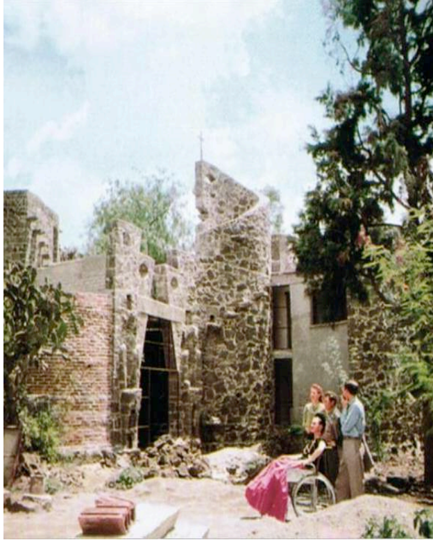
Fig. 29. Casa en construcción
