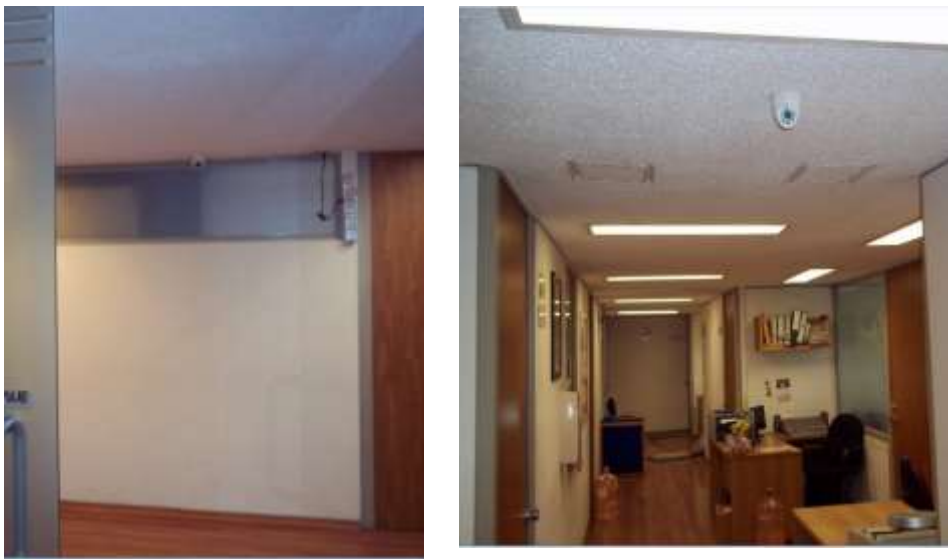
Fig. 3.10 Cámaras interiores en pasillo
