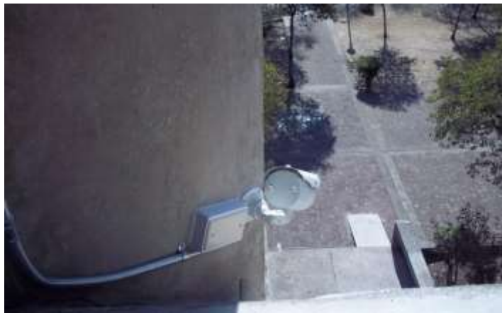
Fig. 3.12 Cámara exterior (Patio)
