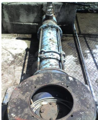
b) Pozo Multifamiliar
