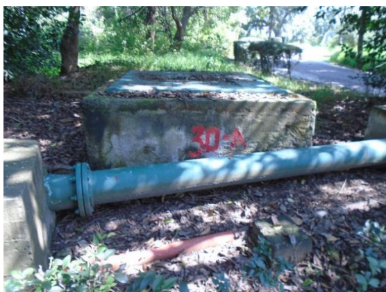
Figura 41 Crucero (30-A), arreglo de válvulas.
