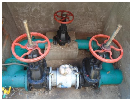
Figura 40 Crucero (31), válvulas.
