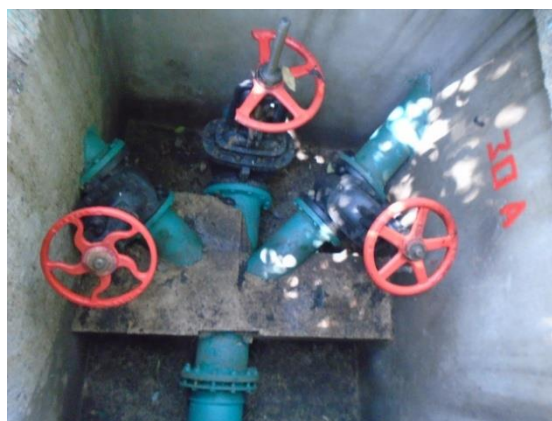
Figura 41 Crucero (30-A), arreglo de válvulas.
