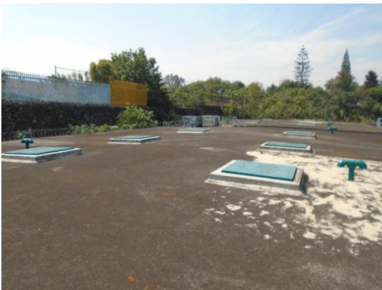
Figura 52 Registro de control y tubería de ventilación de los tanques.
