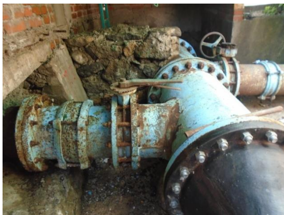
Figura 48 Reducción hacia tanques de regularización.
