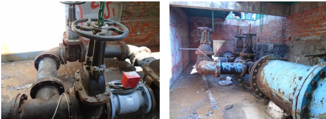
Figura 47 By-pass, arreglo de válvulas y tees de paso con reducción.
