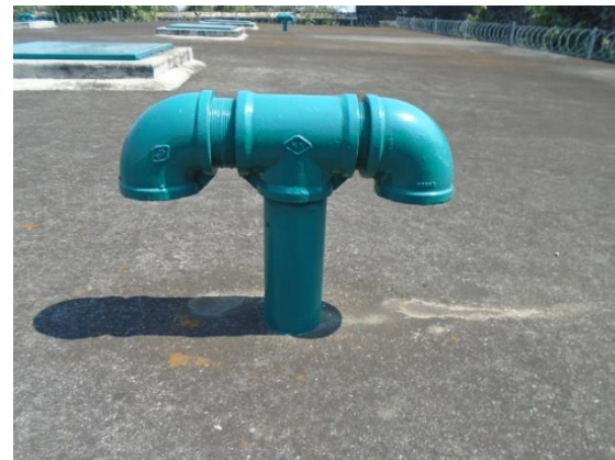
Figura 52 Registro de control y tubería de ventilación de los tanques.
