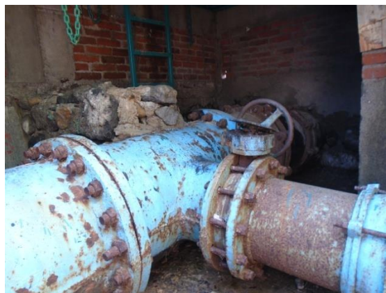
Figura 48 Reducción hacia tanques de regularización.
