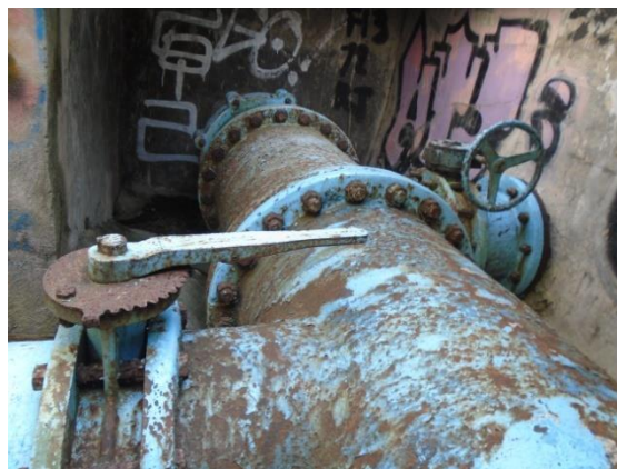
Figura 49 Tees de paso hacia los demás tanques.
