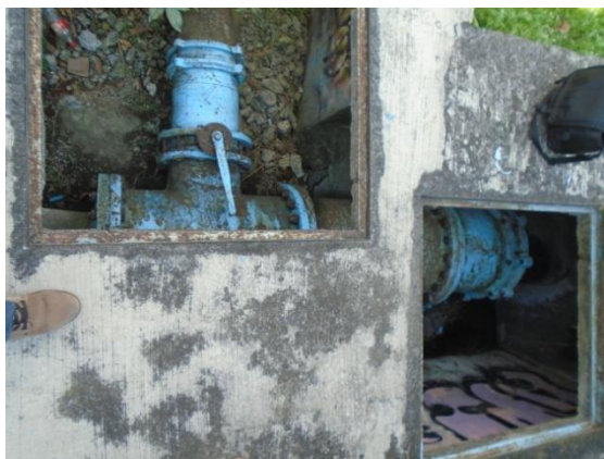
Figura 49 Tees de paso hacia los demás tanques.
