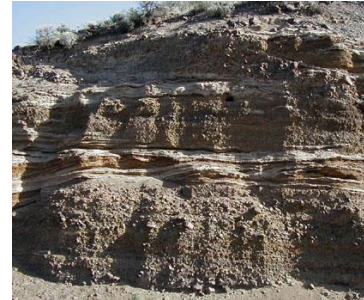
Xonacatlan; suelos aluvi3n duros por la falta de agua.
