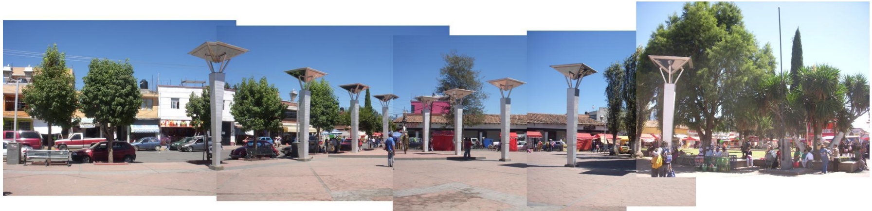
Estructuras en la plaza central sin uso funcional en Xonacatlán.
