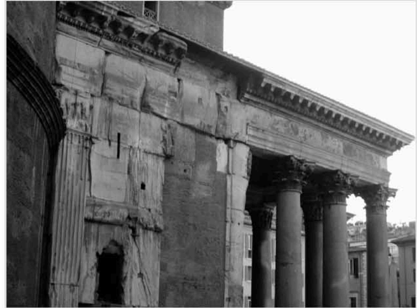
Fig. 22. Panteón , Roma: detalle del pórtico de fachada lateral. [foto de la autora].
