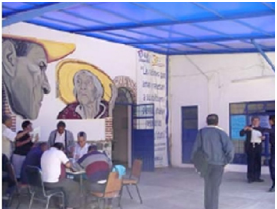
Gráfico Núm. 25.- Vista donde se puede apreciar que las instalaciones no son las óptimas.
