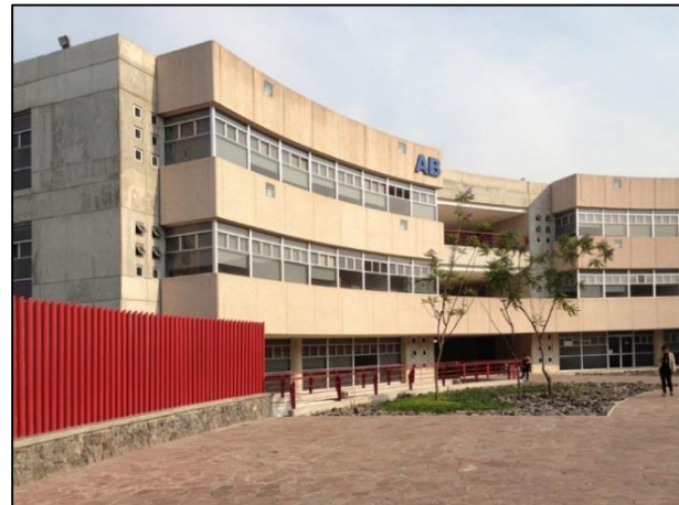
III.IV.III Fachada hacia plaza.
