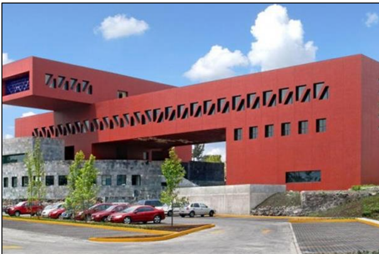
III.III.V. Fachada hacia Insurgentes Sur del Posgrado de la Facultad de Economía. UNAM. www.obrasweb.mx
