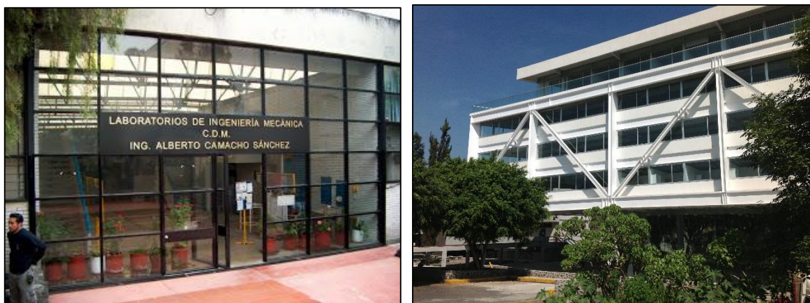
III.V.XII. Derecha: Acceso al Edificio “O”, Izquierda: Centro de Ingeniería Avanzada. Anexo de Ingeniería UNAM
