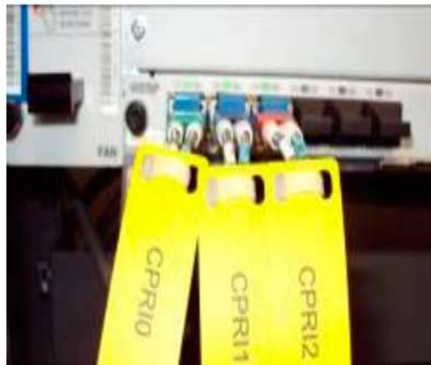
Figura 3.33 Distribución conexión CPRI
