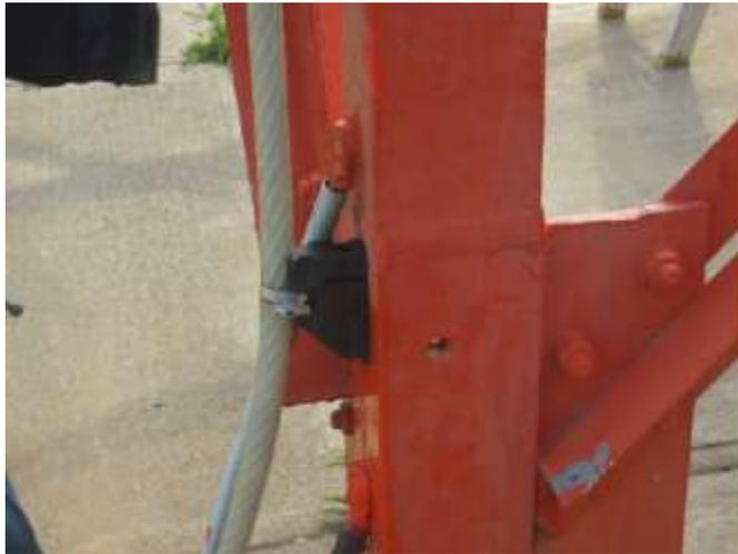
Figura 2.20 Modo de sujeción del cable del pararrayos
