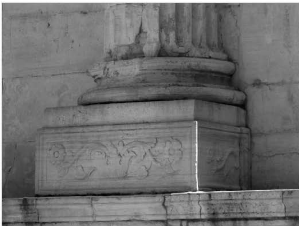
Fig. 54. Leon Battista Alberti, Templo Malatestiano , Rimini, 1447-1450: fachada frontal, detalle de semicolumna, primer orden. [foto de la autora].
