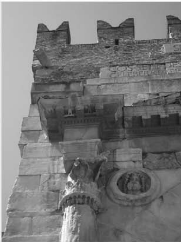
Fig. 21. Arco de Augusto , Rímini, 27 a.C. Detalle de saliente de la cornisa en el muro. [foto de la autora].
