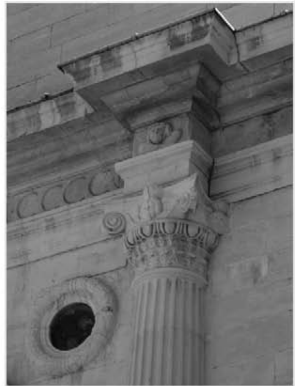
Fig. 22. Leon Battista Alberti, Templo Malatestiano , Rímini, 1447-1450; fachada frontal, detalle de saliente de la cornisa en el muro. [foto de la autora].
