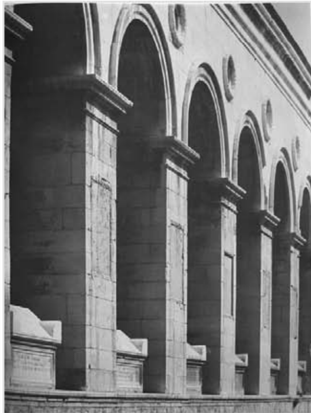
Fig. 60. Leon Battista Alberti, Templo Malatestiano, Rimini, 1447-1450: fachada lateral, lado sur, detalle de arco, pilares, cornisa de imposta y óculos, en Paolo Portoghesi, Il Tempio Malatestiano , Firenze, Sadea/Sansoni, 1963, p. 5.
