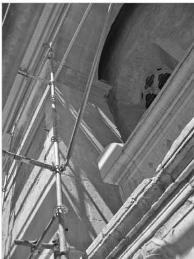
Fig. 38. Leon Battista Alberti, Tempio Malatestiano , Rimini, 1447-1450: fachada frontal, lado sur, detalle de la separación entre el viejo muro de la iglesia y el muro albertiano. [foto de la autora].
