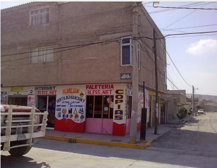
FOTO 8. VISTA ESTE-OESTE. CERRADA VILASECA.
