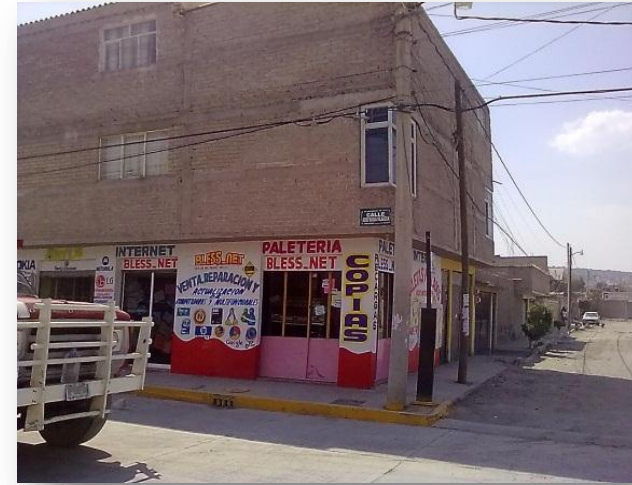
FOTO 20. MUESTRA EN LA ESQUINA DE LA CALLE CERRADA VILASECA UN TELEFONO PUBLICO EN MALAS CONDICIONES.
