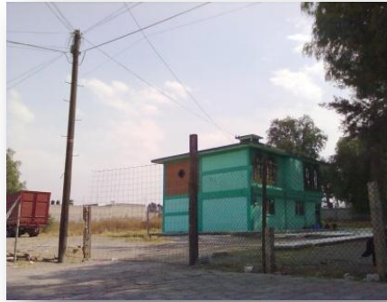
FOTO 1. VISTA NORTE - SUR EN LA AVENIDA IGNACIO ALLENDE.
