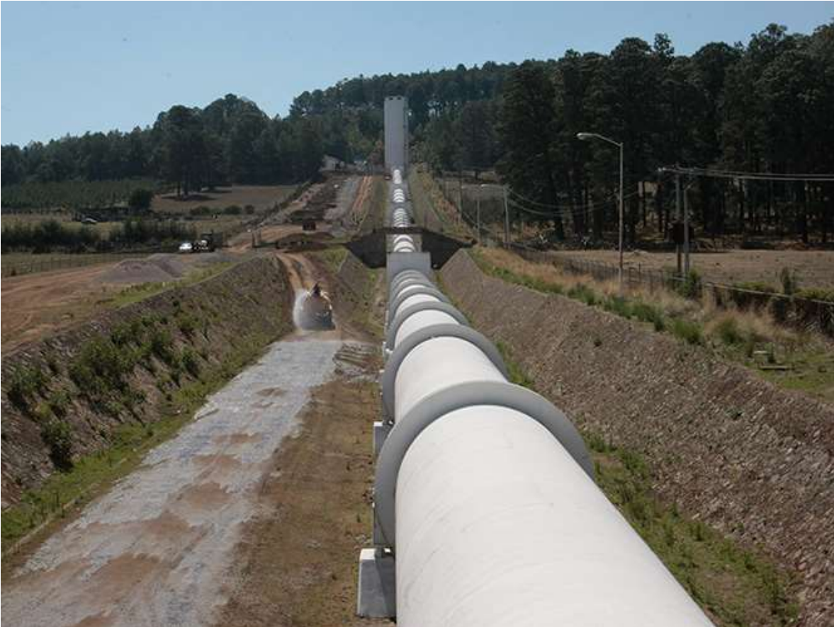
Fig. 3.1 Tercera línea del acueducto Cutzamala. 5
