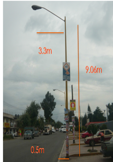
Fotografía 2. Dimensiones de Postes en la Avenida Solidaridad, Chalco Estado de México
