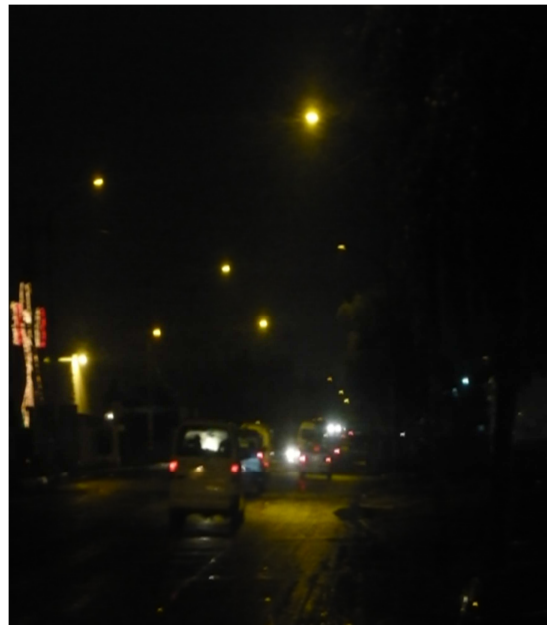
Fotografía 10. Tramo de la avenida que funciona correctamente.
