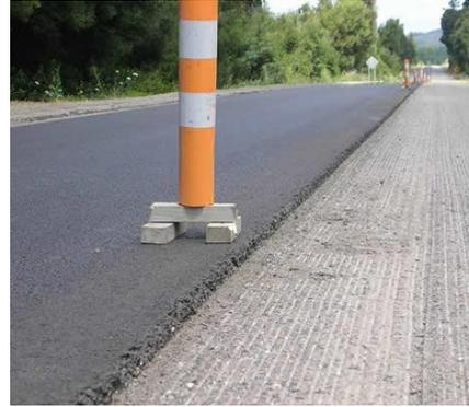
Ilustración 50 Asfalto modificado con caucho reciclado- Fuente: [www.ichasfalto.cl](http://www.ichasfalto.cl) 2010
