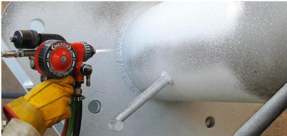
Fig. 1.20 Recubrimiento de zinc por flama oxiacetilénica sobre elemento estructural [24].
