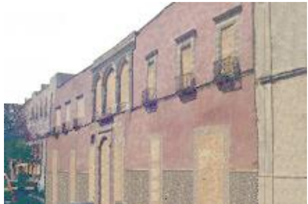
Figura 49.- Fachada principal exterior del Patio de los Generales.
