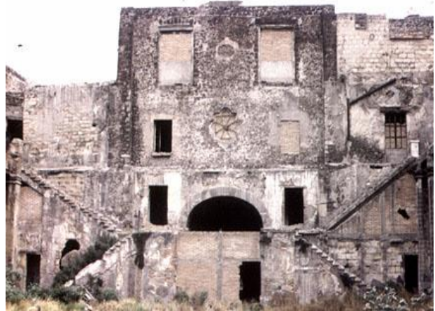
Figura 51.- Fachada interior, crujía oriente.
