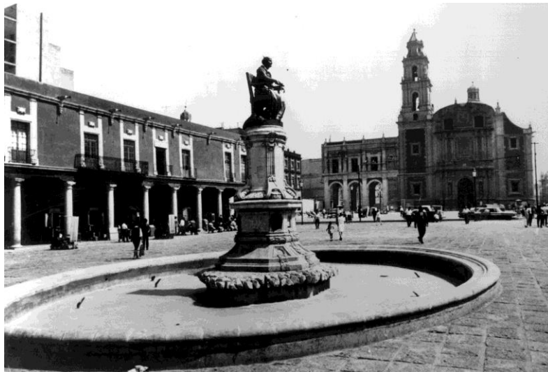
Figura 82.- Fotografía de la Plaza de Santo Domingo, después de su remodelación en 1967, en donde se aprecia la recuperación de la arquería del convento. CNMH-INAH, DCXLIII-28.
