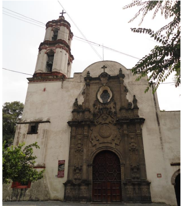
Figura 8.- Fachada principal, Parroquia de los Santos Apóstoles Felipe y Santiago, Azcapotzalco.
