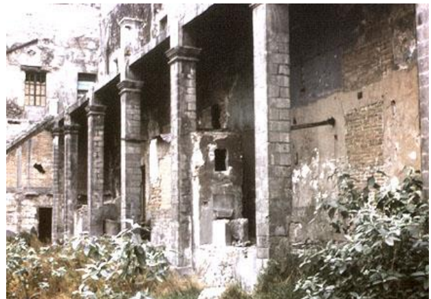
Figura 55.- Fachada interior, crujía sur.
