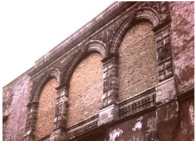
Figura 50.- Detalle, planta alta, fachada principal exterior.
