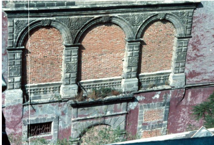
Figura 58.- Arquería del descanso original de la escalera del antiguo convento (1992)
