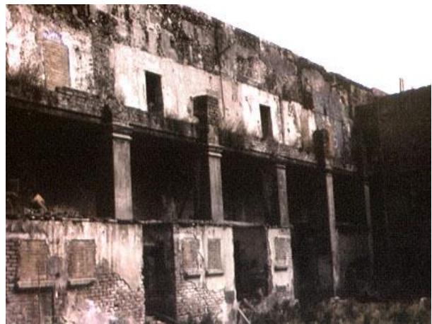
Figura 52.- Fachada interior, crujía norte.
