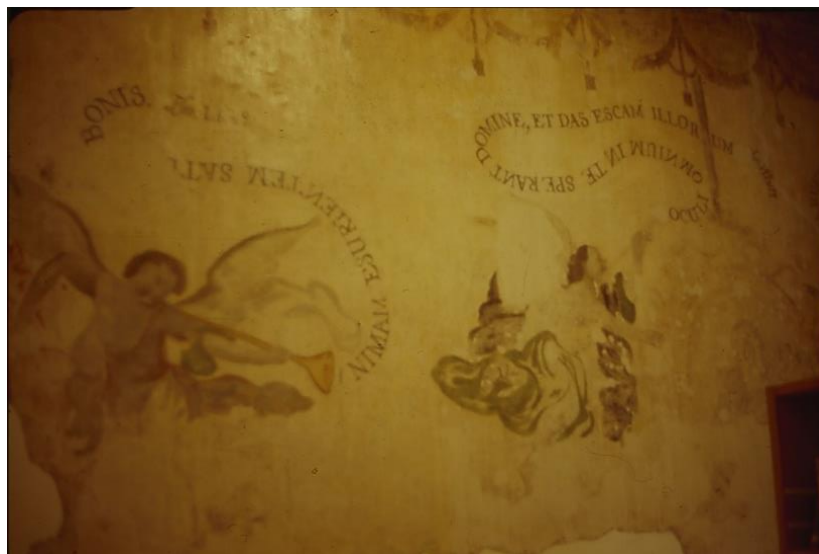
Figura 61.- Pintura mural ubicada al interior de la crujía norte
