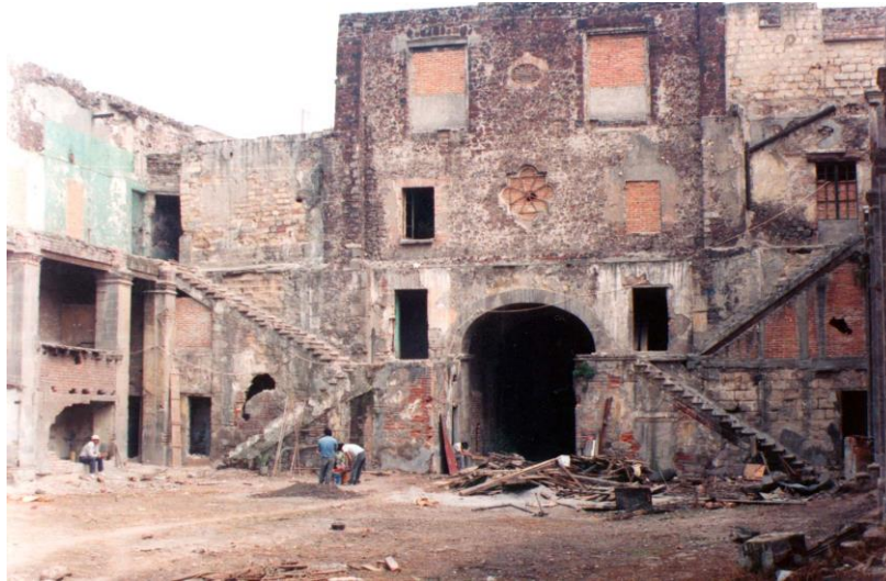
Figura 60.- Fachada interior de la crujía oriente en donde se observan las escaleras adosadas que servían de acceso a las viviendas del nivel superior. (1992)
