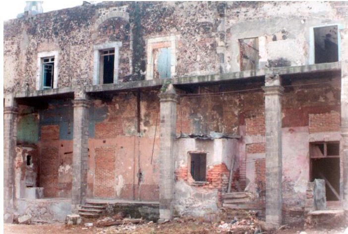
Figura 64.- Fachada de la crujía sur, se aprecia el alto grado de alteración del monumento (1992)
