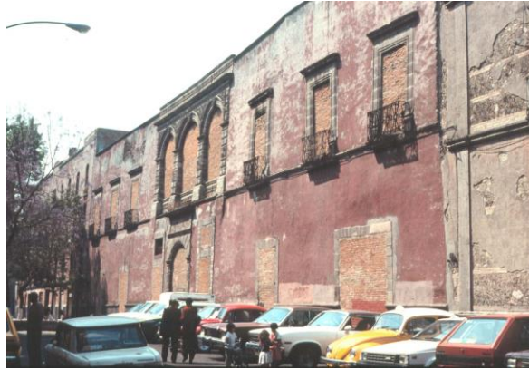
Figura 56.- Fachada principal del inmueble ubicado en la calle Leandro Valle no. 20, Antiguo Patio de los Generales. (1992)
