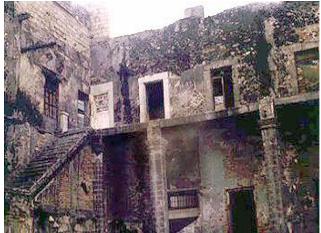
Figura 54.- Fachada interior, crujía sur.
