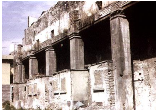
Figura 53.- Fachada interior, crujía norte.
