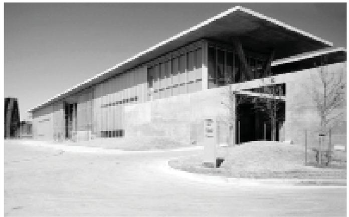
Para la cubierta se utilizó una losa maciza de concreto armado pasando sobre la columna en “Y” de acero. Debido al tamaño de estos volados (24 pies a lo largo y 56 pies a lo ancho), se propuso un sistema de post-tensado en el sentido transversal para proveer a la estructura capacidad a la tensión y deflexión.
