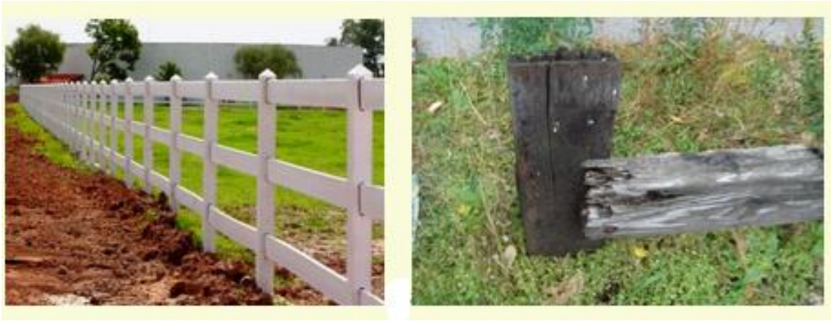
Imagen 4.22 Comparación de la plastimadera® contra la madera de una cerca.
