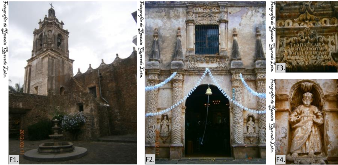
Imagen 8. F1-F2. Fotografía del perfil y frente principal de la Parroquia El Divino Salvador de Ocotepéc; fundada en 1536 con orden de Hernán Cortez (documentos del Archivo General de la Anáhuac en el Archivo General de la Nación). F3-F4. Detalle fotográfico en el relieve del frente con mensajes en latín sobre la transfiguración del señor y con figuras de frayles franciscanos F4.
