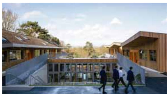
Vista a las aulas de la parte trasera del complejo.
