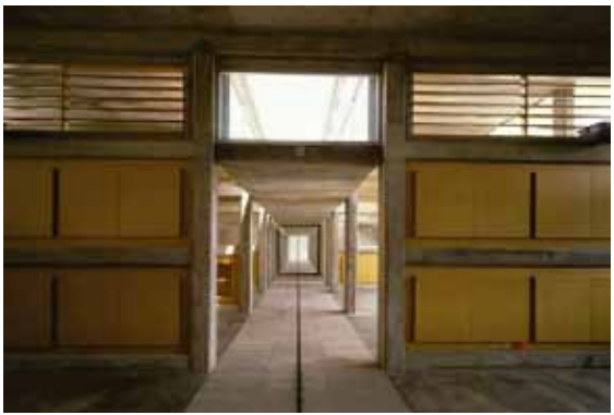
Marcos rectangulares de concreto y techos planos.
