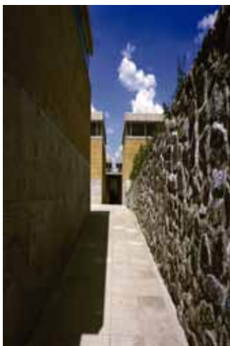
Muros de tepetate sobre basamento de concreto.
