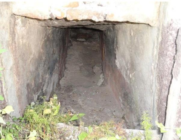
Imagen 167. Ramal de conducción de los reservorios exteriores a la hacienda, hacia los aljibes interiores. Foto del autor
