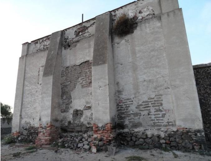
Imagen 160. Detalle de contrafuertes.
