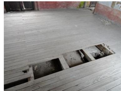
Imagen 92. Detalle del sistema constructivo del entepiso en planta alta a base de duela de madera
