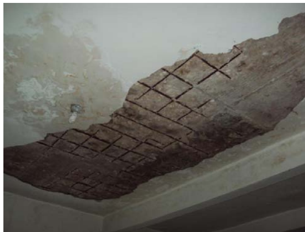
I.3. Interior del inmueble, Piso 3.
