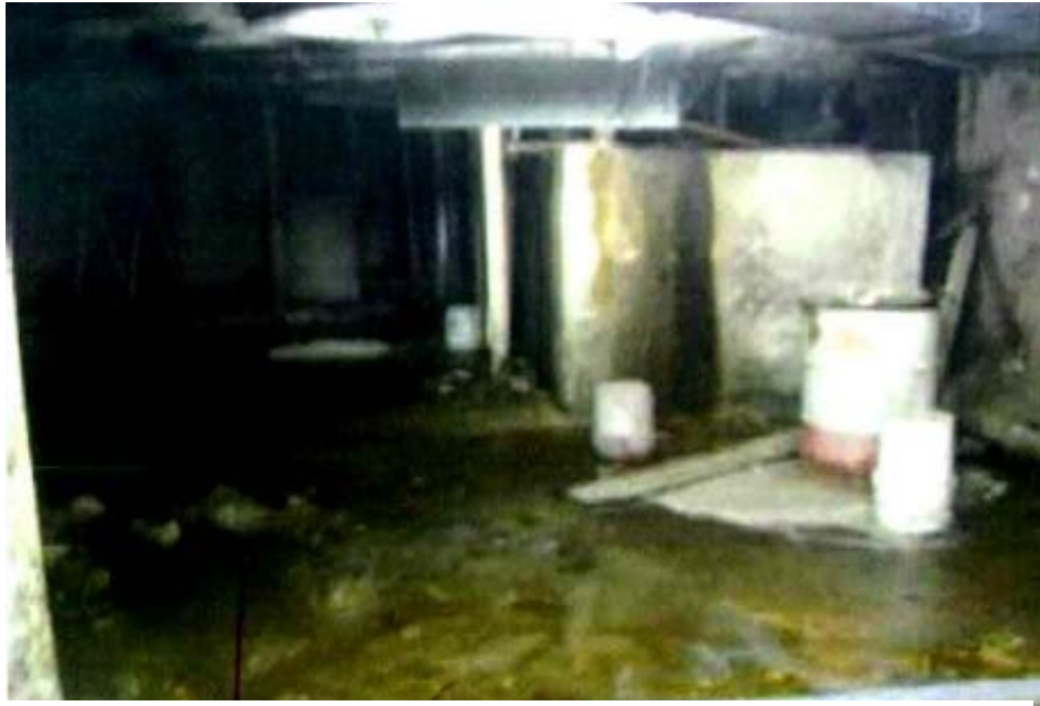
I.15. Interior del inmueble, Sótano 2
