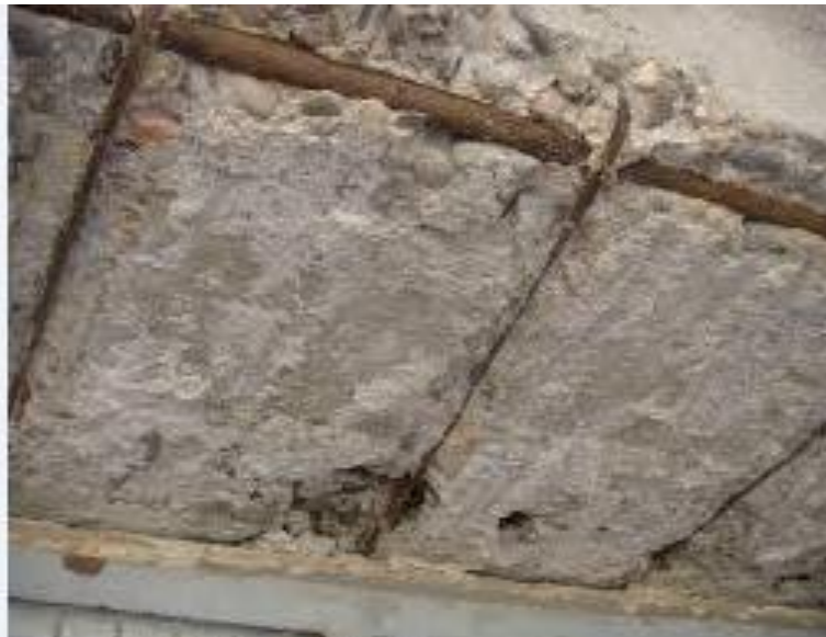
I.4. Interior del inmueble, Piso 4, Eje F 1-2.
