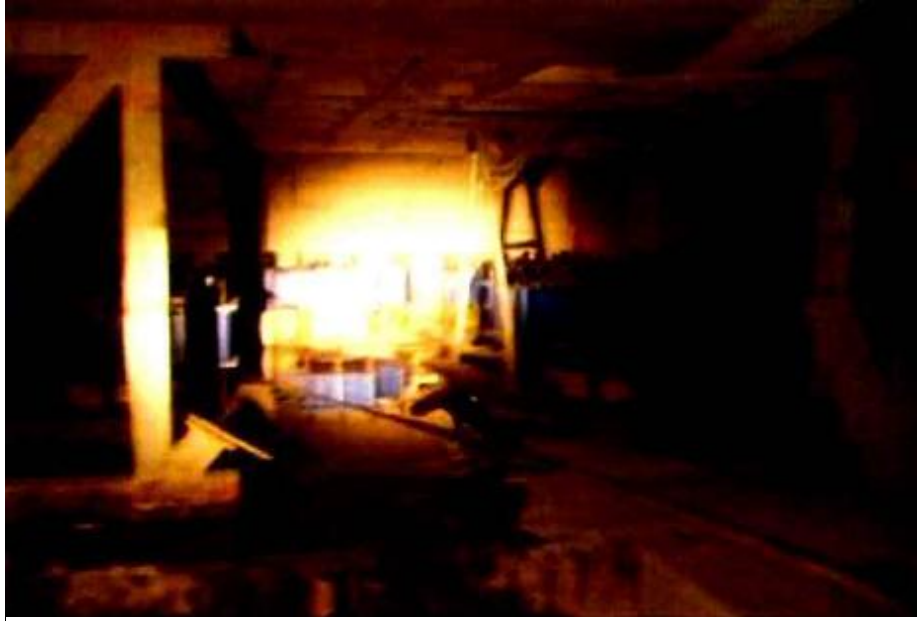
I.18. Interior del inmueble, Sótano 1
