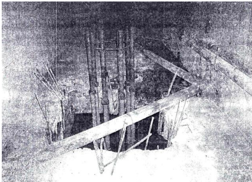
I.31. Interior del inmueble, Sótano 2.
