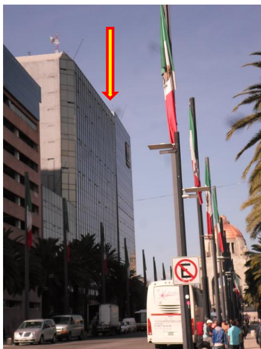
I.8. Se observa la falta de verticalidad y el apoyo que hace el edificio No. 140 sobre el No. 141.
