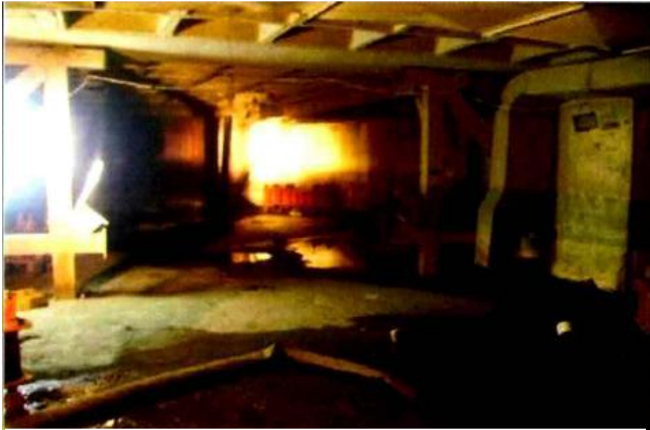
I.9. Interior del inmueble, Sótano 1
