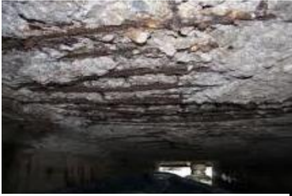
I.19. Interior del inmueble, Sótano 1
