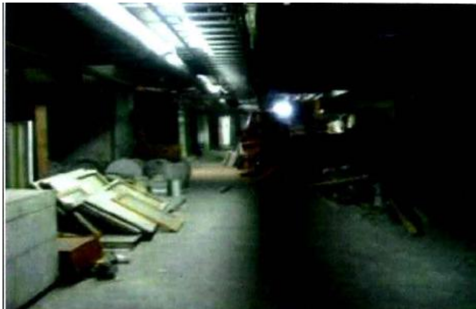
I.12. Interior del inmueble, Sótano 1
