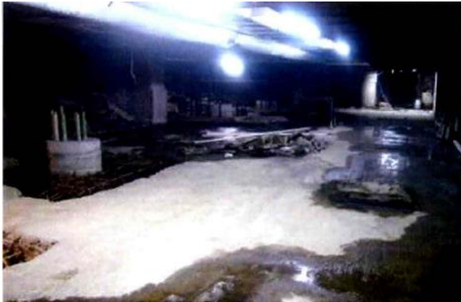
I.11. Interior del inmueble, Sótano 2
