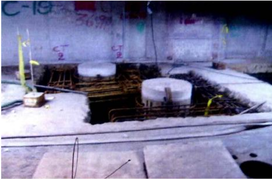
I.13. Interior del inmueble, Sótano 1
