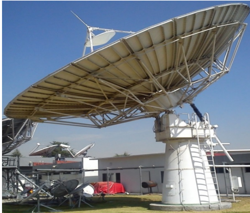
Fig. 3-2 Antena Parabólica tipo Cassegrain
