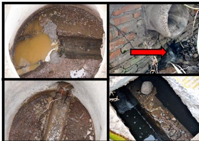
**Fig. 30** Se muestran los dos tipos de descarga presentes (arriba y abajo; lqz.), y dos detalles del sistema de alcantarillado que está fuera de las capacidades de funcionamiento correcto y las ruptura de la estructura que implica contaminación directa.
