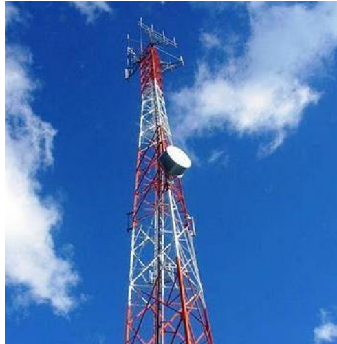
Figura 2.24 Torre auto soportada
