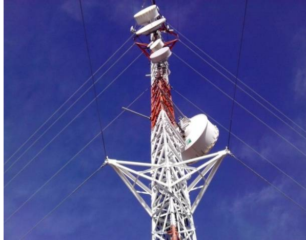
Figura 2.25 Torre arriostradas o atirantada
