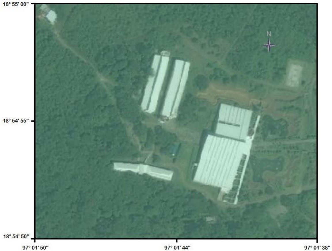
Figura 2.1.2 Vista de los edificios del campus USBI Ixtac con coordenadas (Global Mapper).
