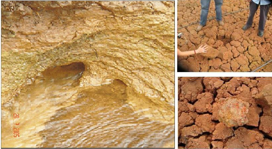
Figura 2.4.2. A la izquierda, se aprecia el agua fluyendo a través de las arcillas. A la derecha, arcillas agrietadas debido a la pérdida de humedad (Francisco Arredondo, Universidad Veracruzana).
