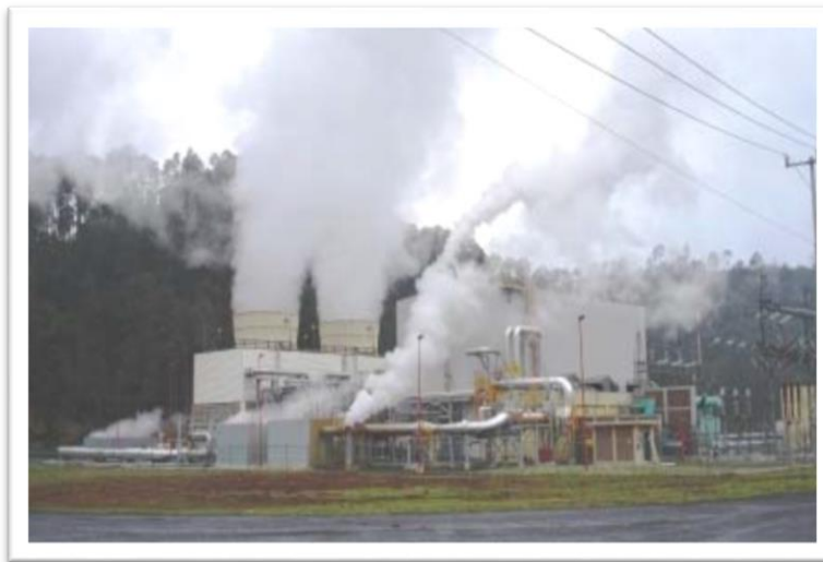
Ilustración 6 Central Geotermoeléctrica Los Azufres
