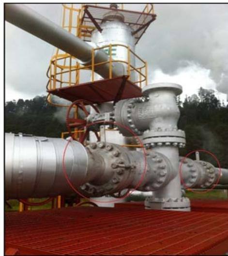
Figura 2.11 Placas orificio instaladas en boca de pozo.
