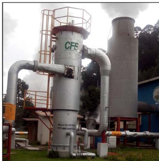
Figura 3.31 Separador de vapor de la central geotermolétrica Los Azufres.
