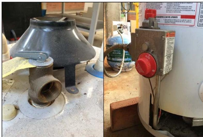
Figura 3.27 Válvula de alivio y termostato.
