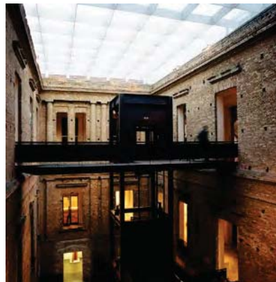
Elevador en patio interior
