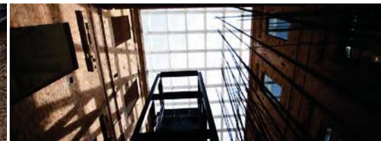
Cubierta sobre edificio
