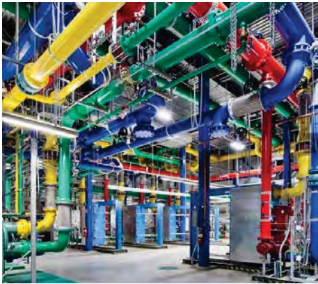
Color de tuberías indica el tipo de fluido
