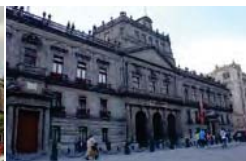
Exterior, Palacio de Minería.
