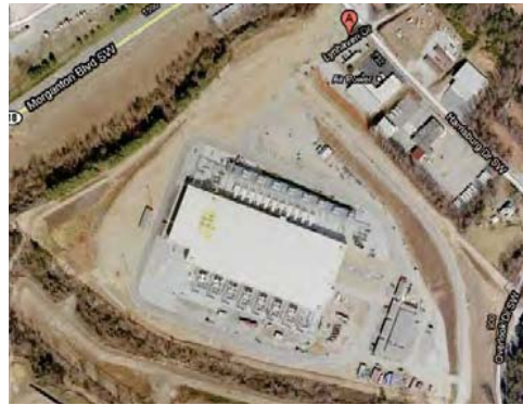
Planta *fuente gráfico: http://www.google.com/about/datacenters/
