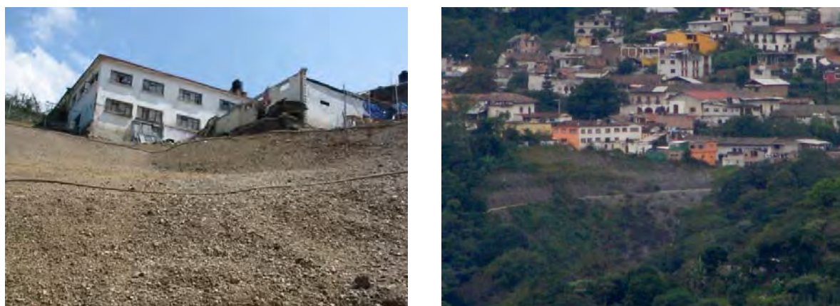
Figura 13. Afectaciones por el deslizamiento del 2007 en el área de la Clínica municipal (izquierda) y medidas de mitigación estructural implementadas (derecha).
