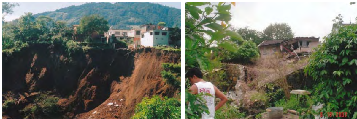
Figura 12. Deslizamiento del 2007 ocasionado por fuertes precipitaciones en la calle 5 de mayo.
