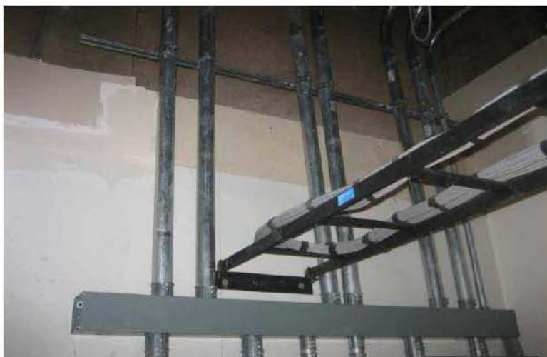
**Figura 1.9 Distancias de trabajo (separación) de sistemas de fuerza y de control.**
