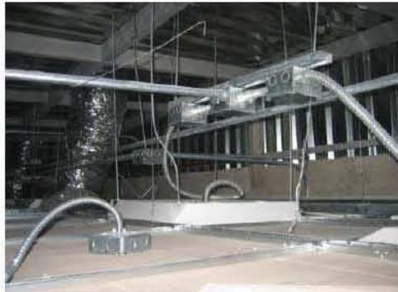
Figura 1.2 Instalación eléctrica parcialmente oculta
