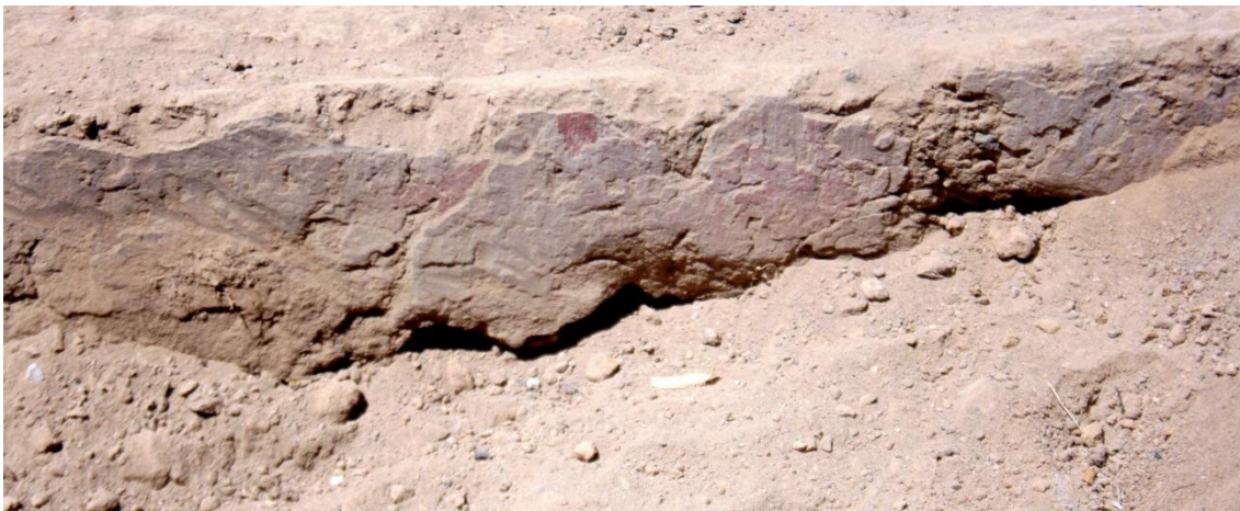
Figura 30. Muro oeste de la habitación en Pórtico 2 con restos de pintura roja
