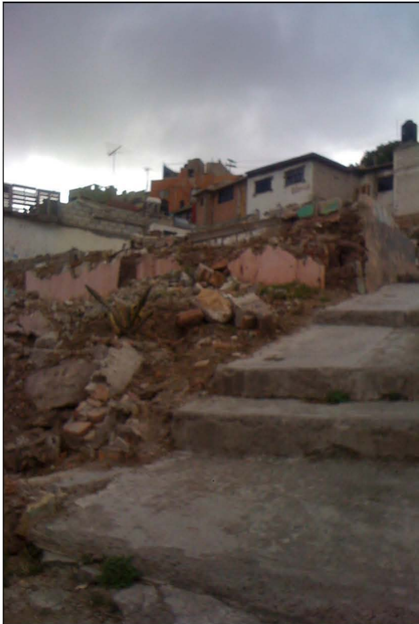
Figura 23. Zona de derrumbe. Fotografía: Antonio Ramírez. Febrero, 2012.
