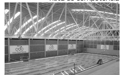
Vista de la cubierta
