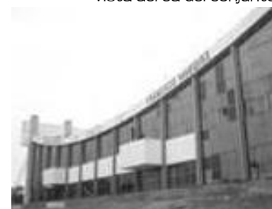
Fachada principal del gimnasio
