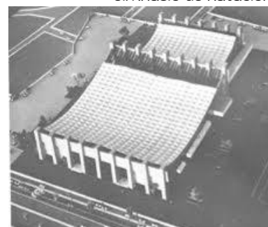
Vista aérea del conjunto
