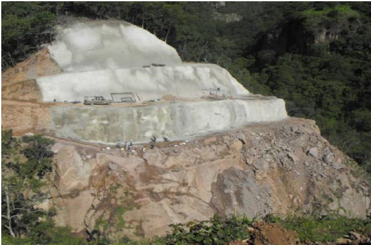
(Fig. No. 49) Secuencia constructiva de excavación y protección de talud con concreto lanzado
