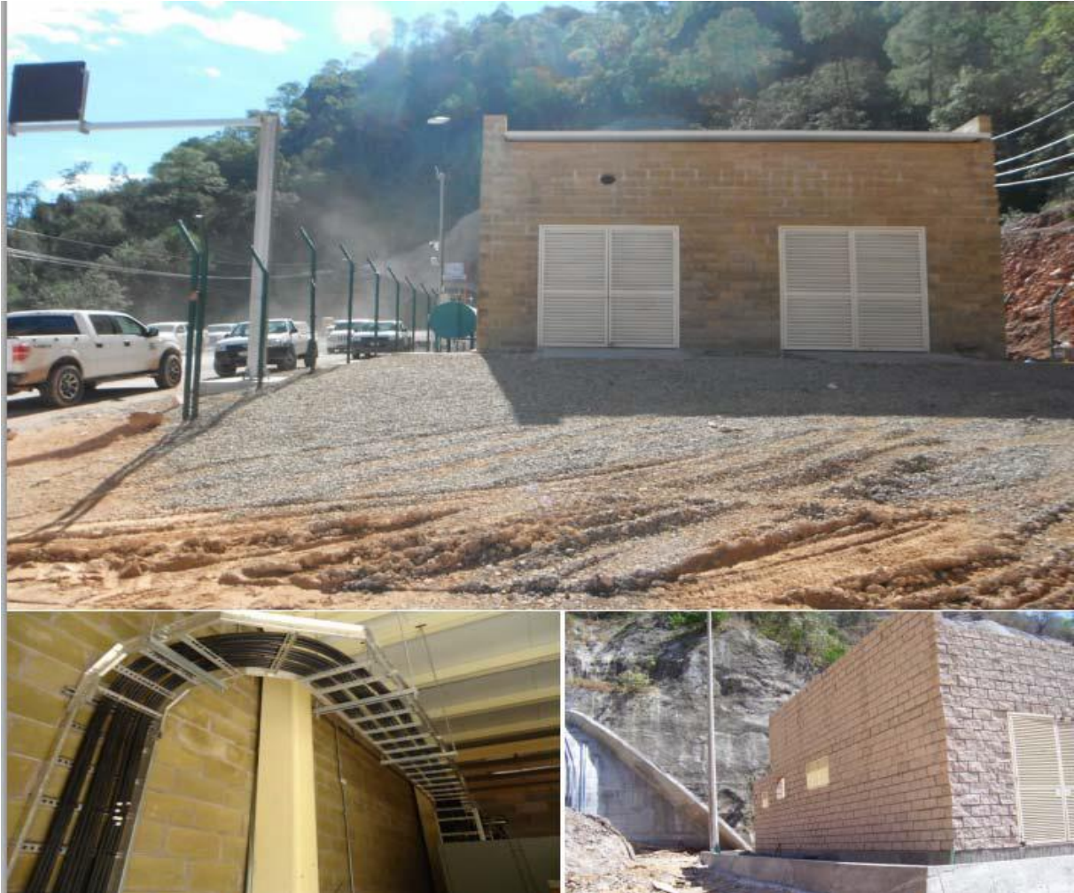
Fig. No. 160 Cuarto de Maquinas
