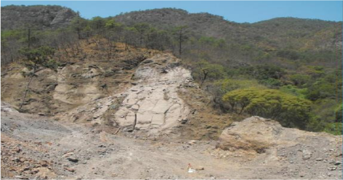
Fig. No. 40 Desmonte del portal Durango
