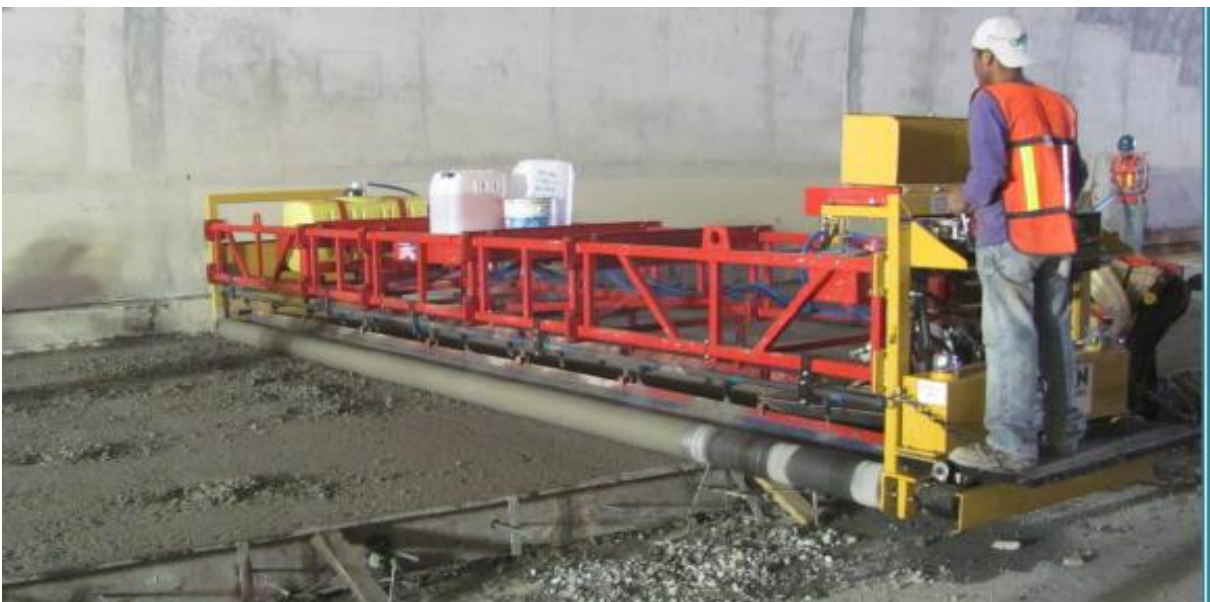
Fig. No.146 Colocación de concreto en pavimentos
