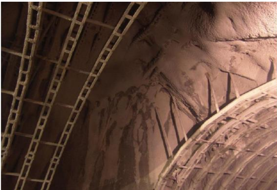
Fig. No. 126 Conclusión de la reparación del caído
