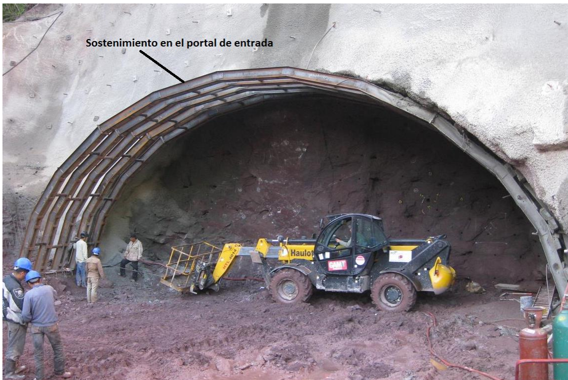
Fig. No. 69 Sección completa con sostenimiento
