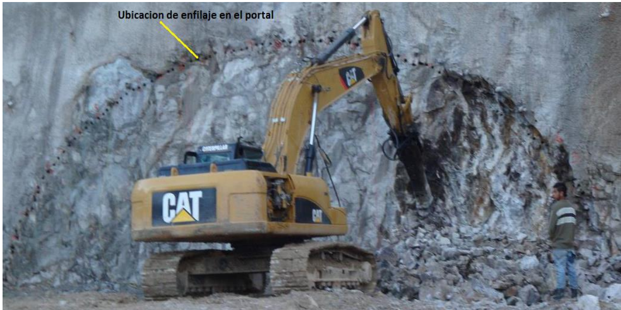
Fig. No. 135 Enfilaje en el portal.
