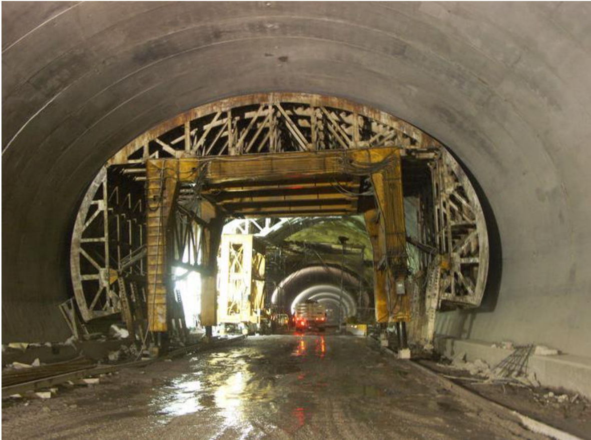
Fig. No. 143 Acabado de recubrimiento final
