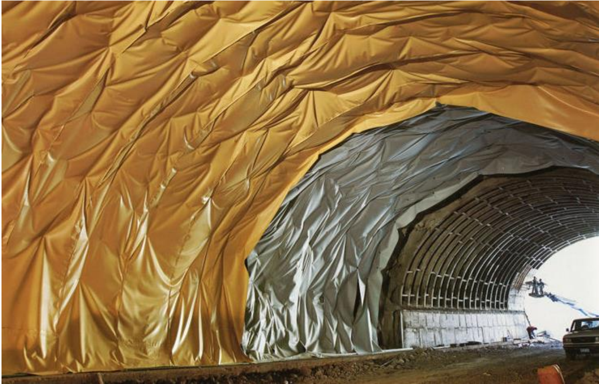
Fig. No. 139 Instalación de geotextil
