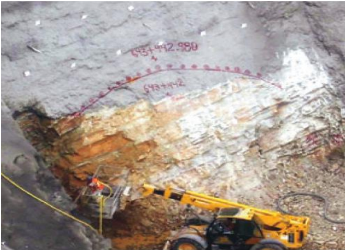
Fig. No. 59 Replanteo para las barrenaciones de enfilaje
