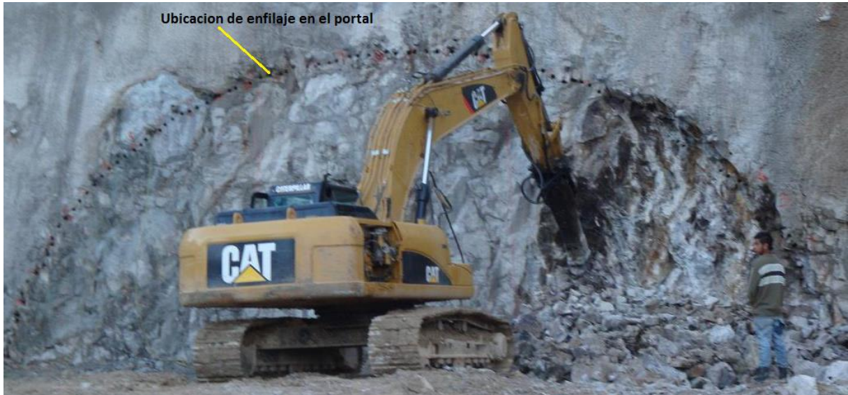
(Fig. No. 67) Inicio de la Excavación del túnel.
