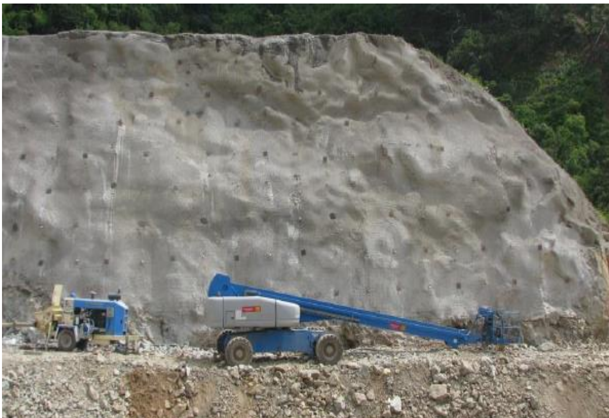
(Fig. No. 52) Equipo de izado y colocación de anclas
