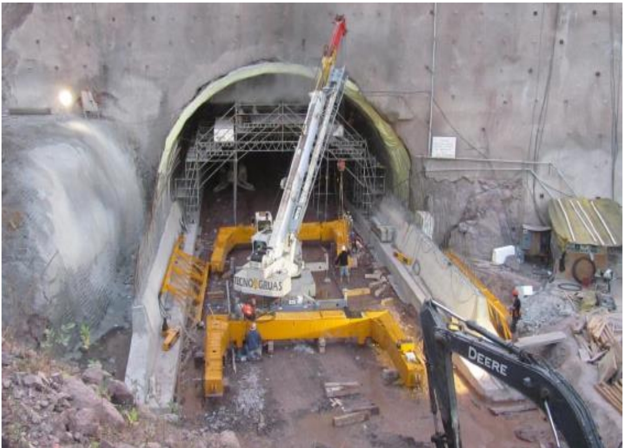
Fig. No. 141 Construcción de zapatas
