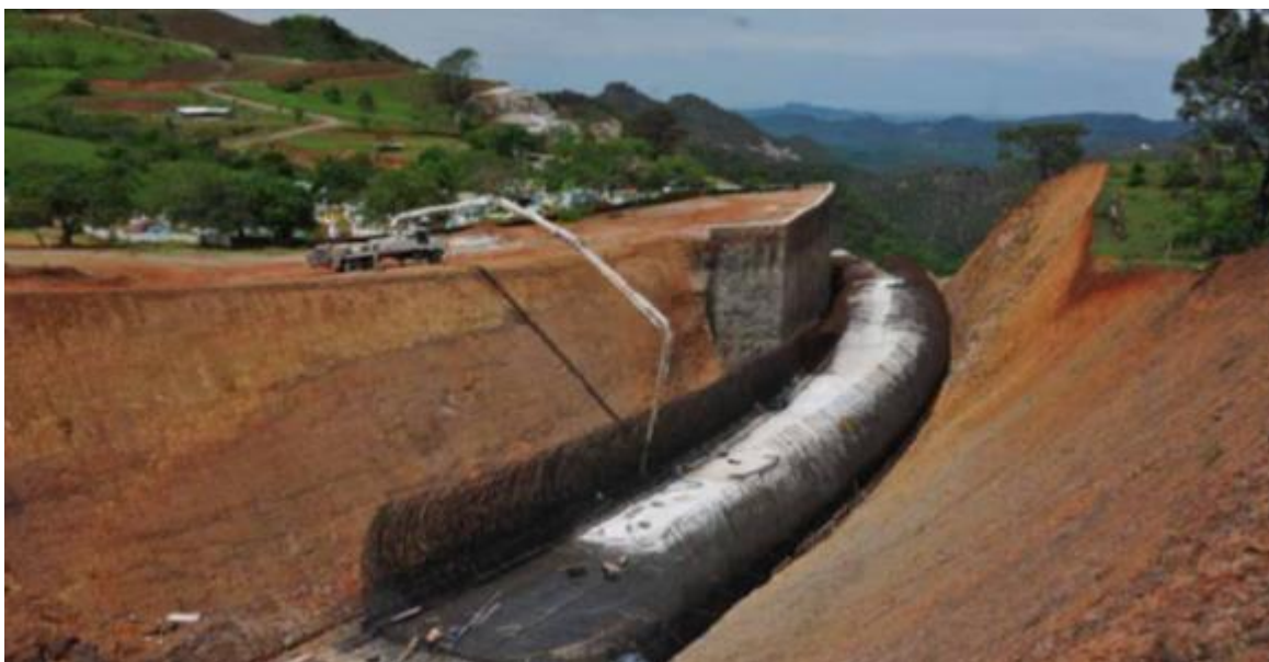
Fig. No. 163 Panorámica del Túnel Santa Lucía I,
