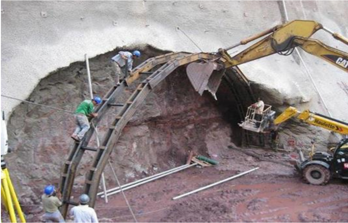
Fig. No. 68 Colocación de sostenimiento por medio de marcos metálicos
