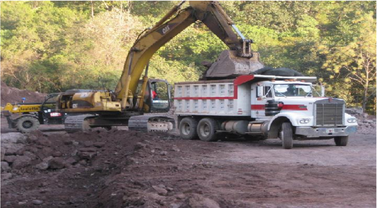
Fig. No. 47 Equipo utilizado para retiro de rezaga.
