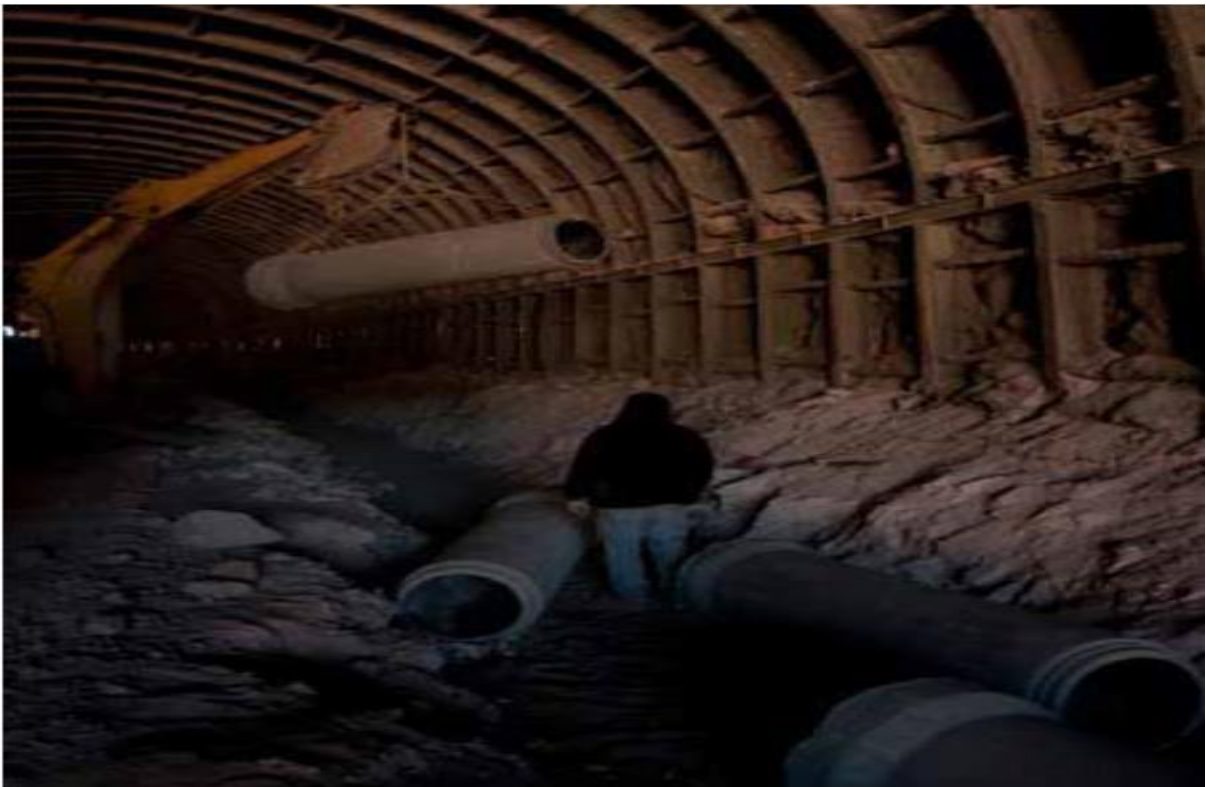
Fig. No. 147 Drenaje al interior del túnel el sinaloense
