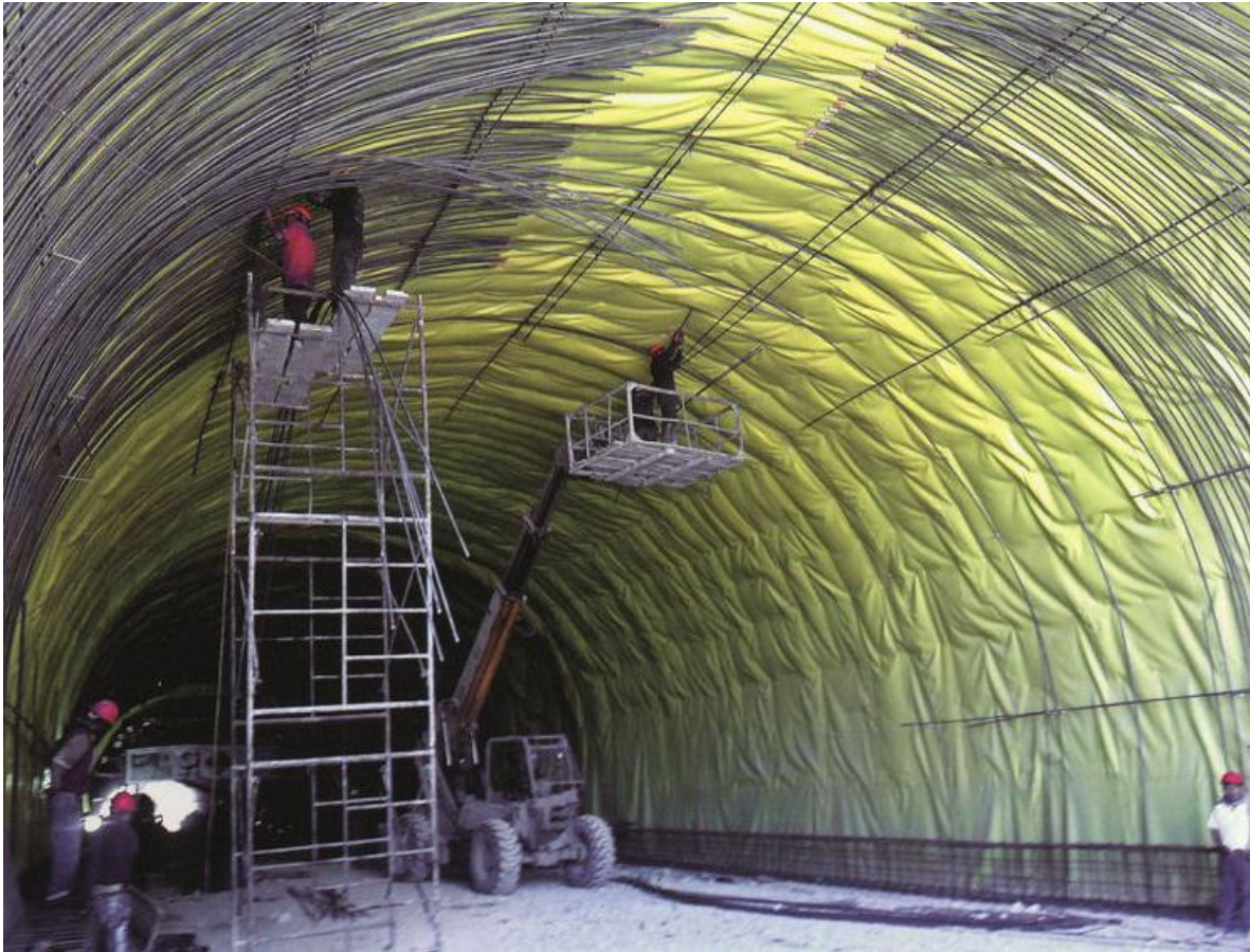
Fig. No. 140 Instalación de Geomembrana
