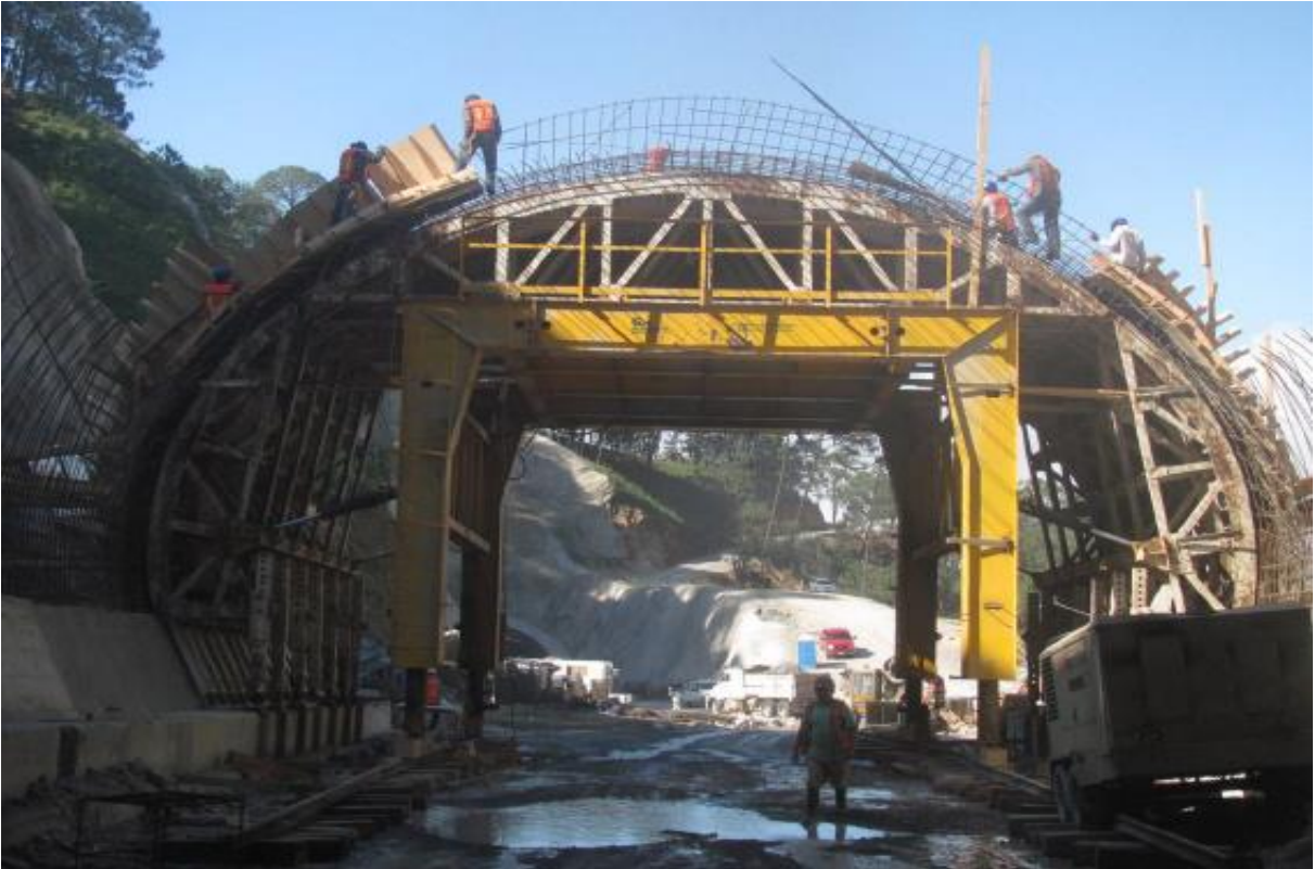
Fig. No. 164 Habilitado de Cimbra en el Túnel falso
