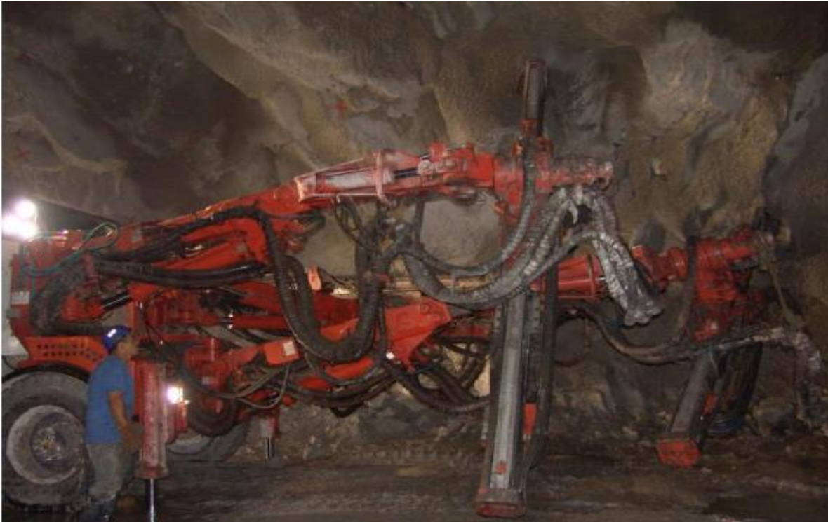
Fig. No. 113 Perforación para colocación de anclas de fricción
