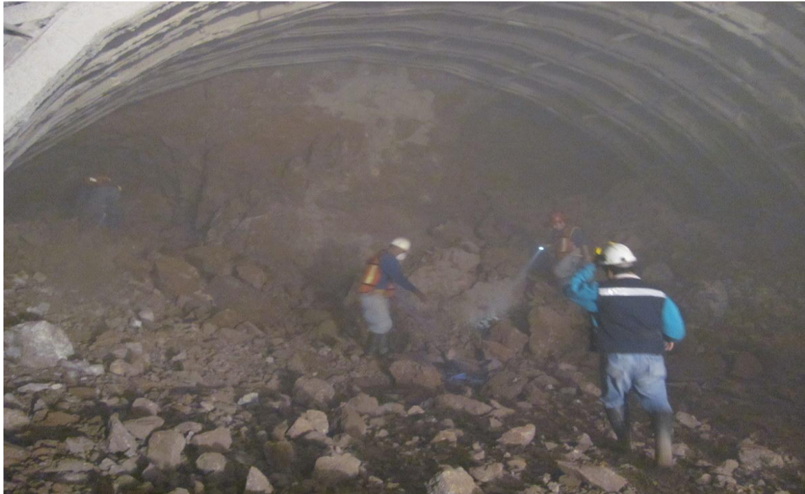
Fig. No. 96 Personal verificando que todo el explosivo haya detonado.
