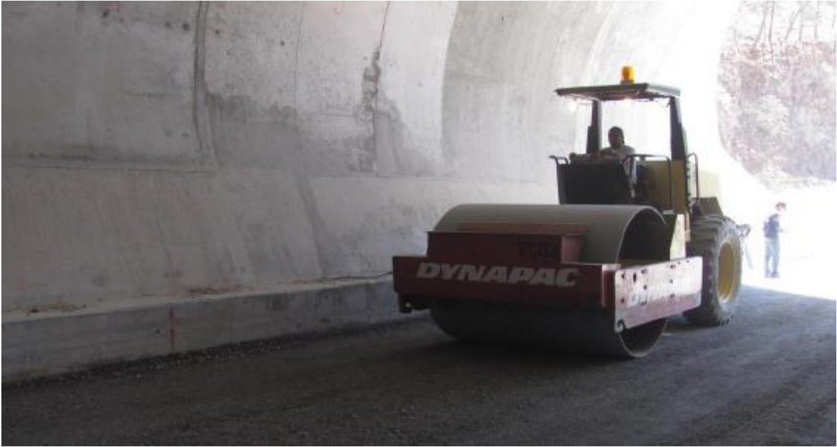
Fig. No. 145 Colocación de la base hidráulica
