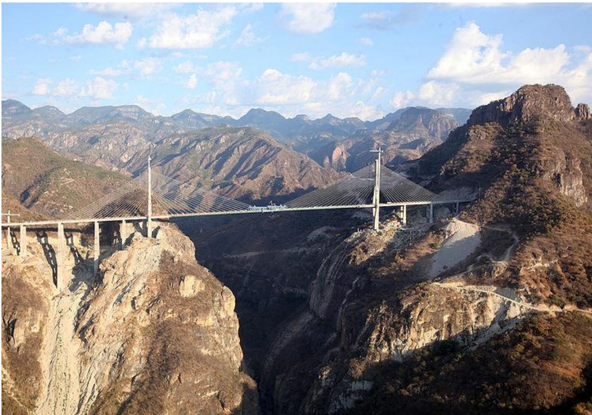
Fig. No. 4 Puente el Baluarte. Autopista Durango - Mazatlán
