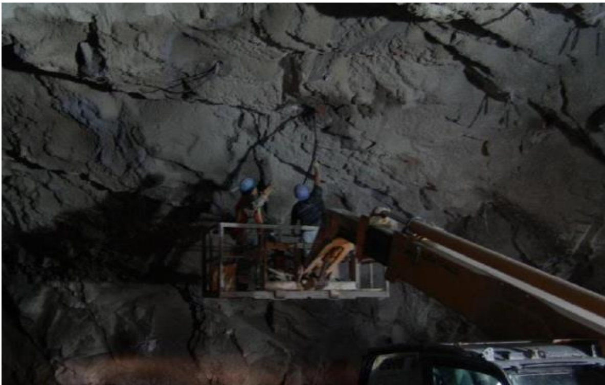
Fig. No. 114 Colocación de anclas de fricción
