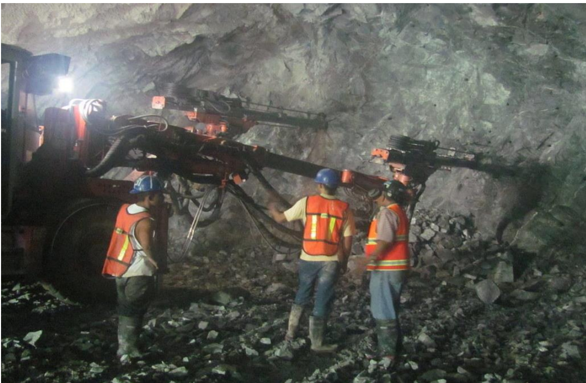
Fig. No. 94 Barrenación en Sección Bóveda
