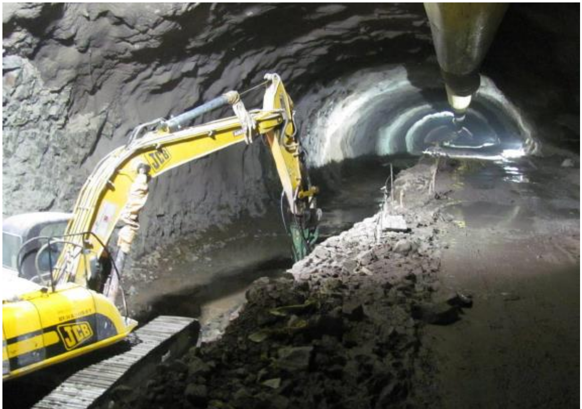
Fig. No. 79 Excavación del banquito “C(+)”
