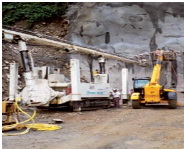
Fig. No. 62 Equipo realizando inyección de lechada
