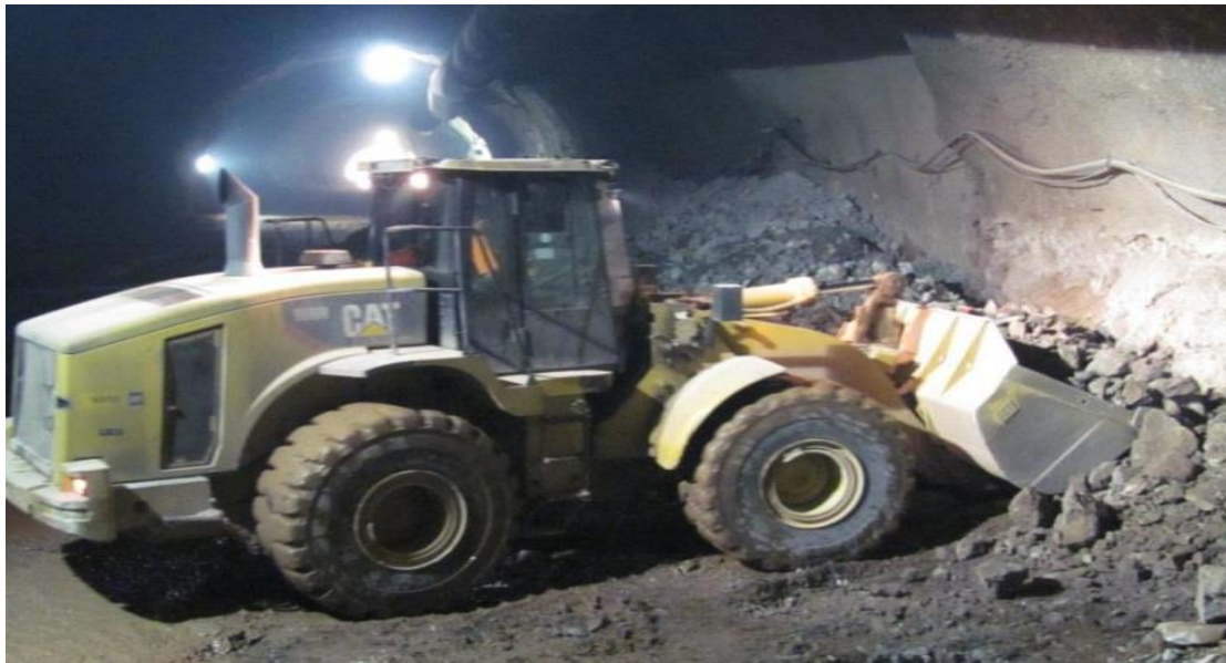
Fig. No. 98 Cargador frontal adecuando el acceso
