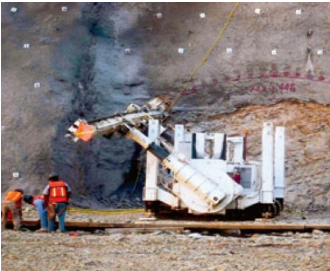
Fig. No. 60 Equipo perforando para colocar los tubos de enfilaje
