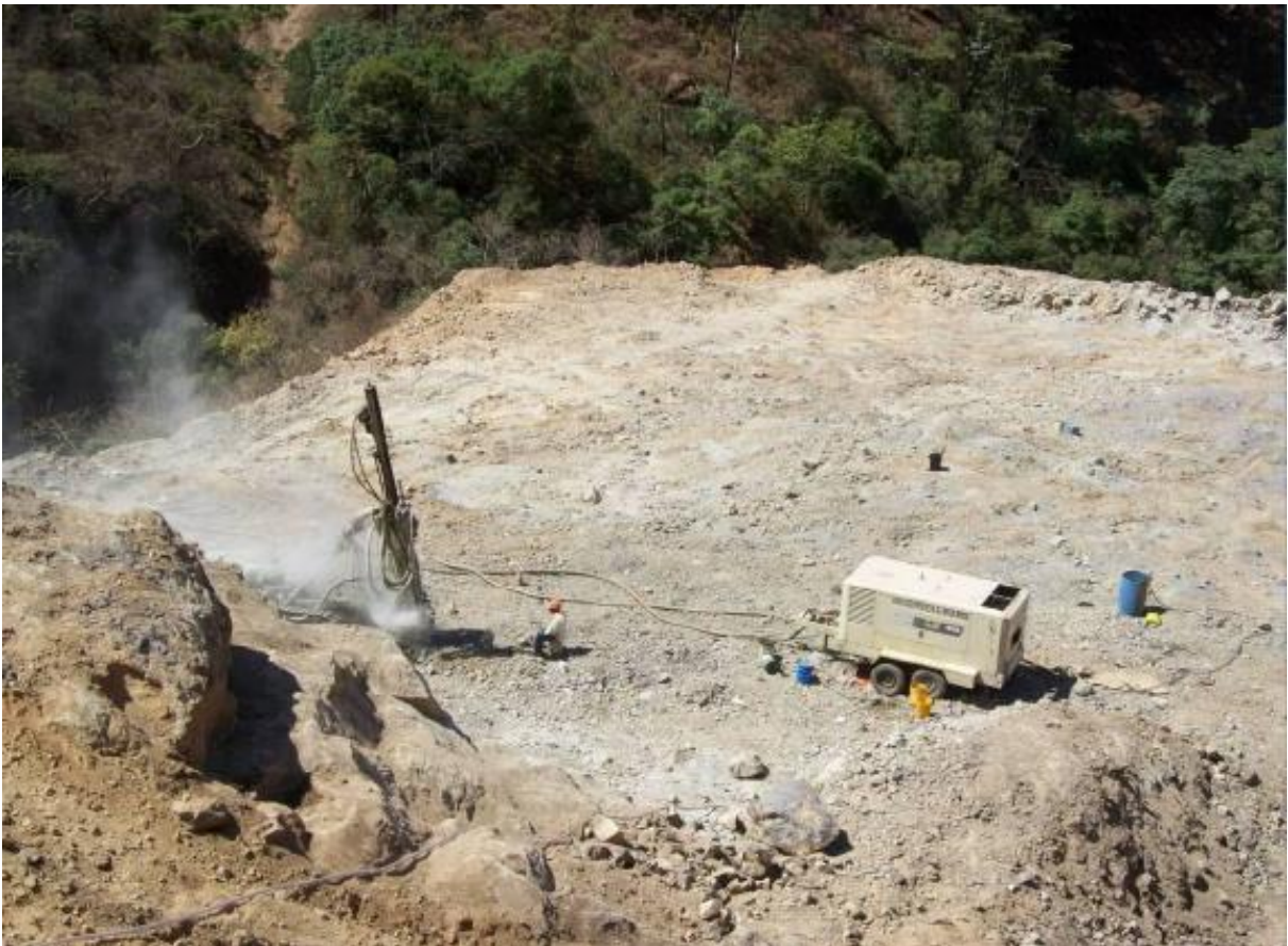
Fig. No. 44 Equipo realizando barrenación en línea
