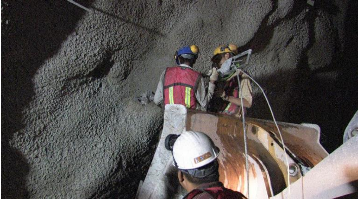
Fig. No. 115 Inyección de lechada en las anclas
