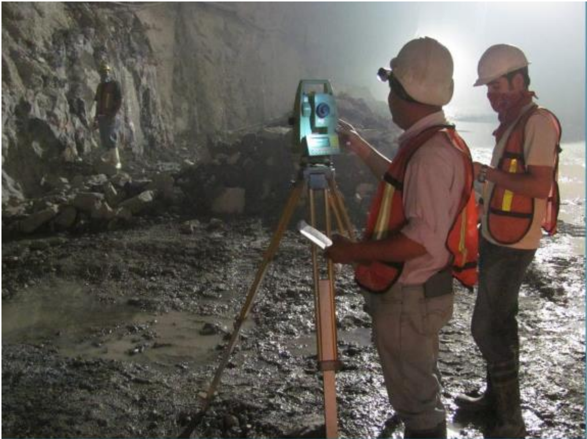
Fig. No. 99 Cuadrilla de topografía verificando que no haya desviaciones
