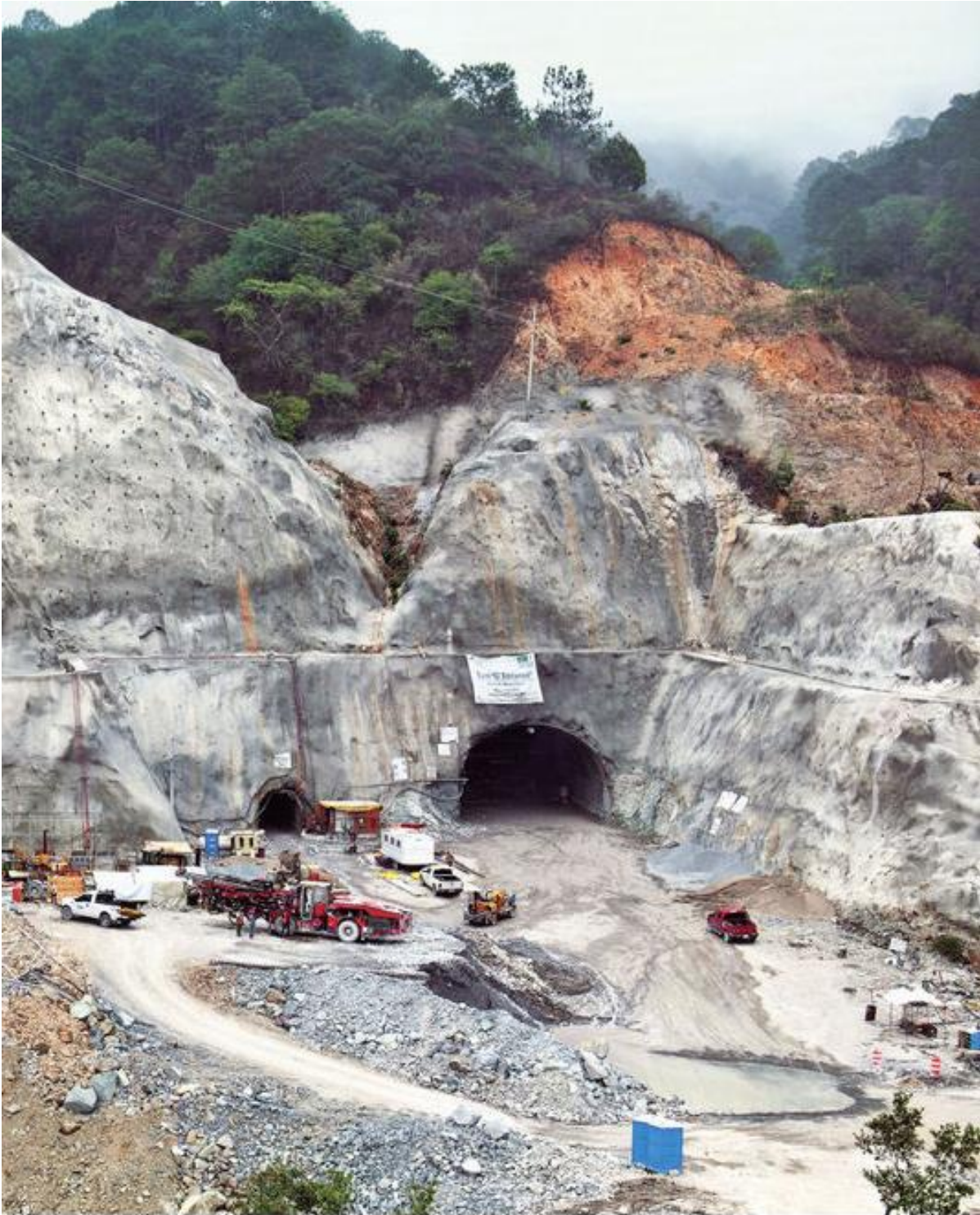
Fig. No. 11 Portal de entrada del Túnel Sinaloense
