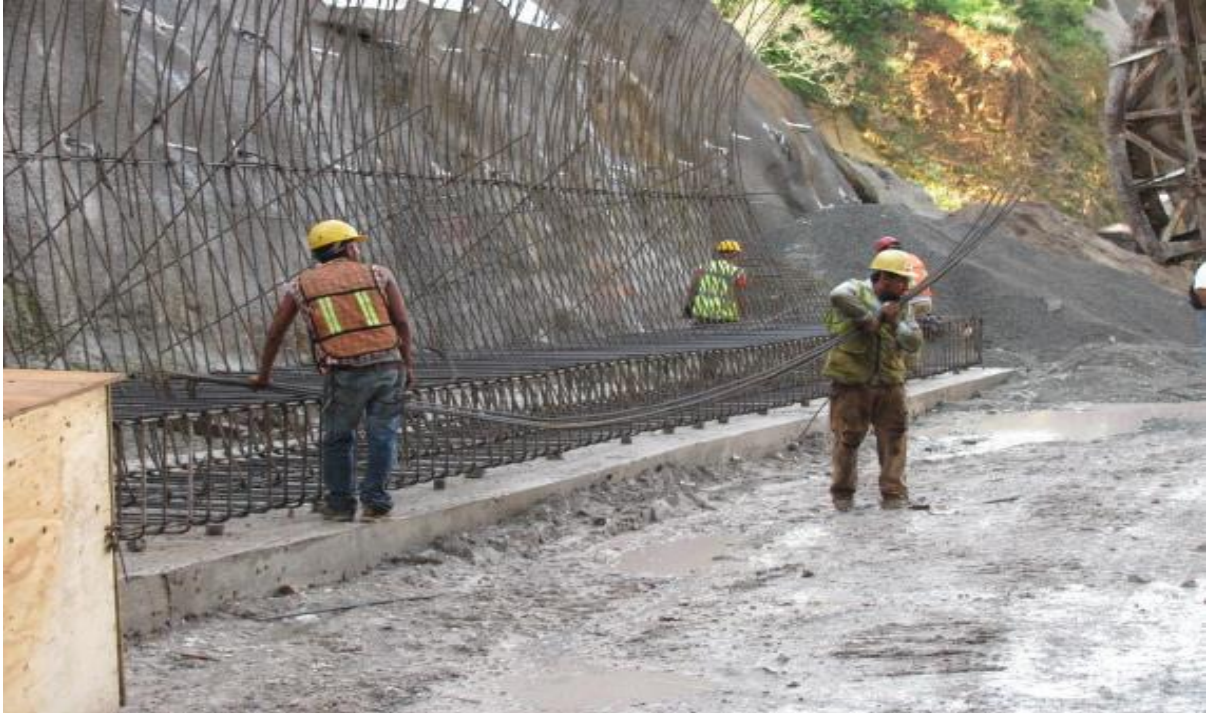
Fig. No. 162 Fabricación de Zapatas para el túnel falso
