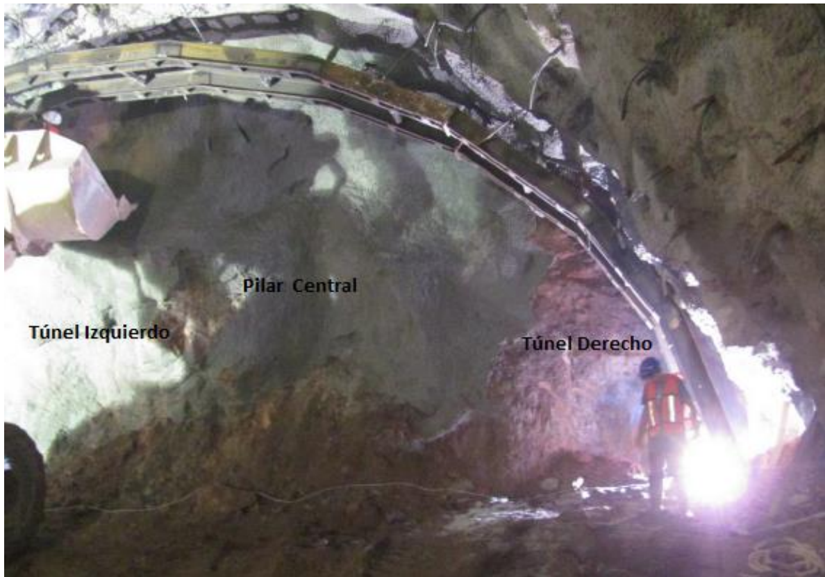
Fig. No. 120 Colocación del sostenimiento definitivo
