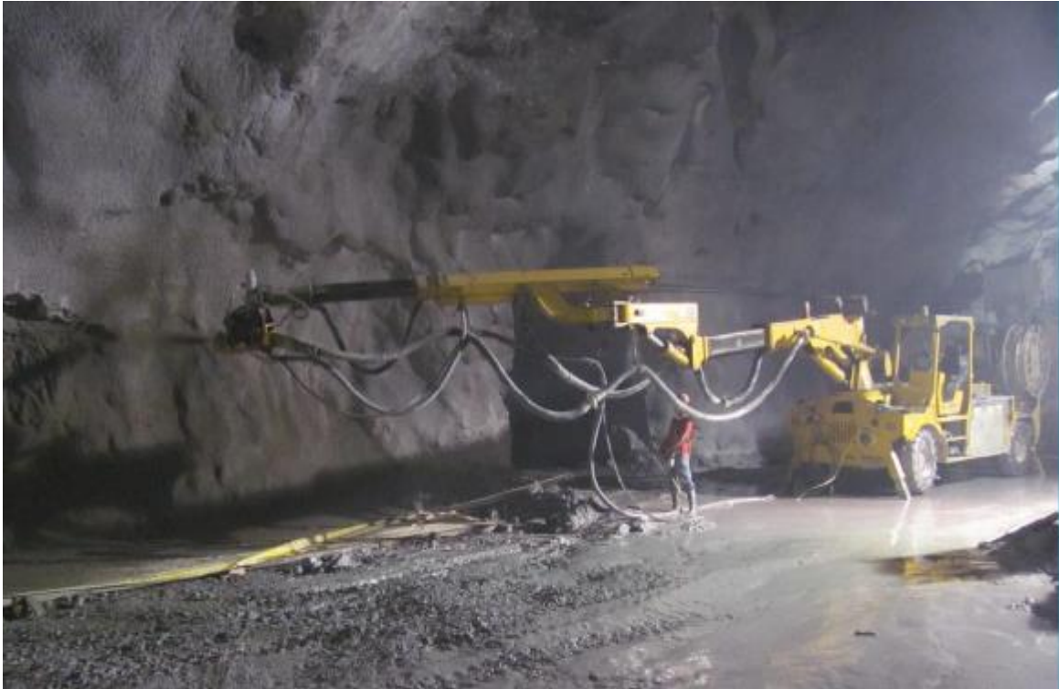
Fig. No. 136 Equipo de lanzado de concreto
