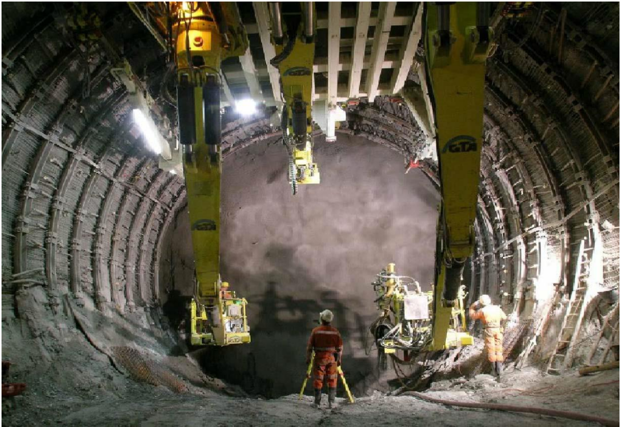
(Fig. 138) Recubrimiento con concreto lanzado reforzado con fibra metálica
