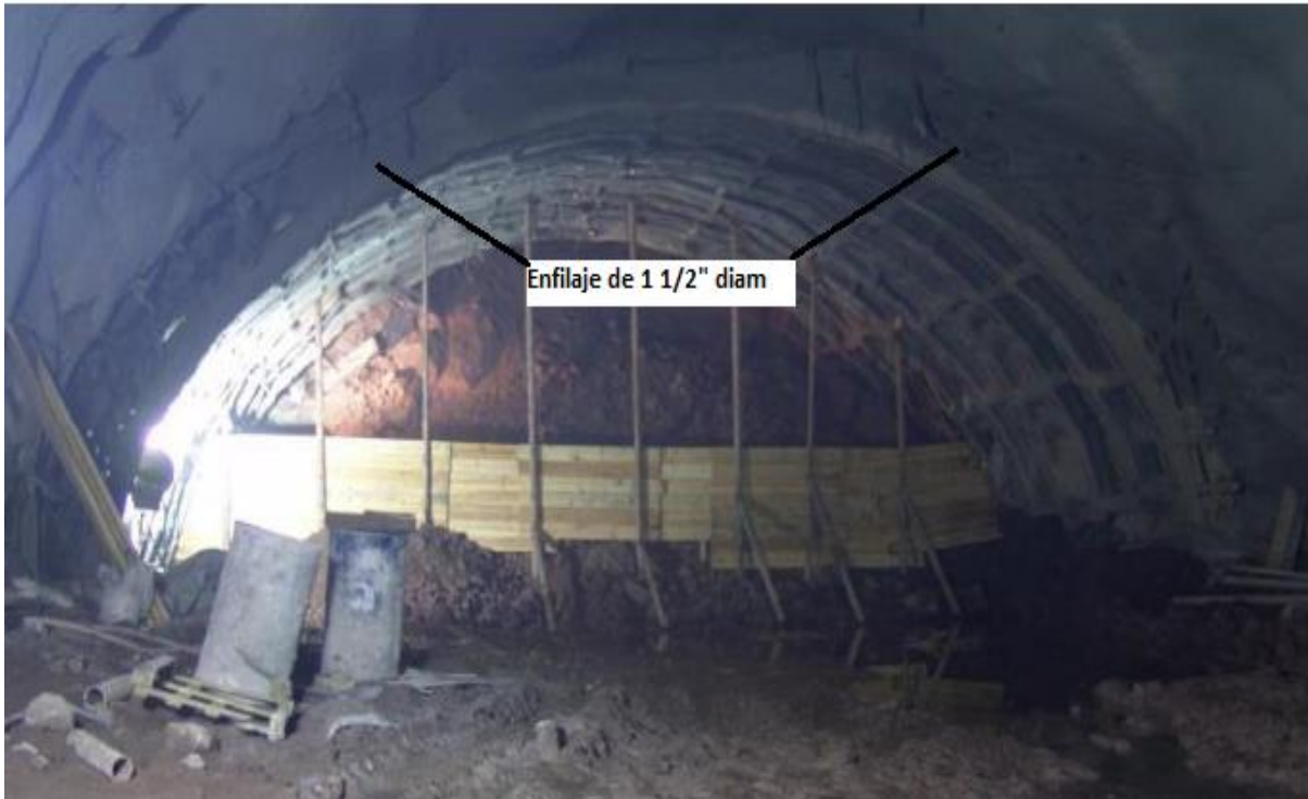
Fig. No. 134 Colocación de enfilajes
