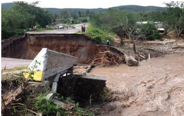
Figura 4.5 Colapso del puente Petaquillas
