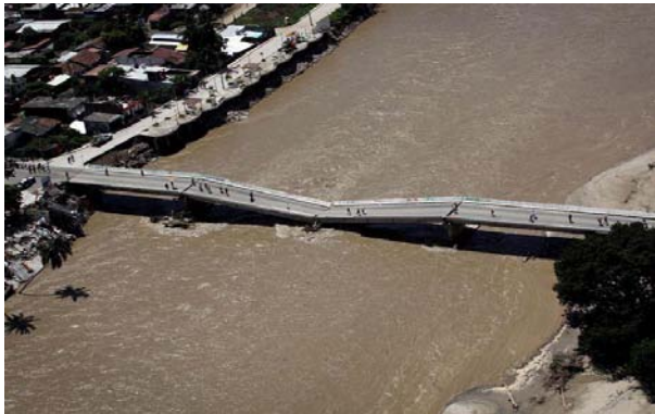
Figura 4.4 Daño puente Coyuca de Benítez
