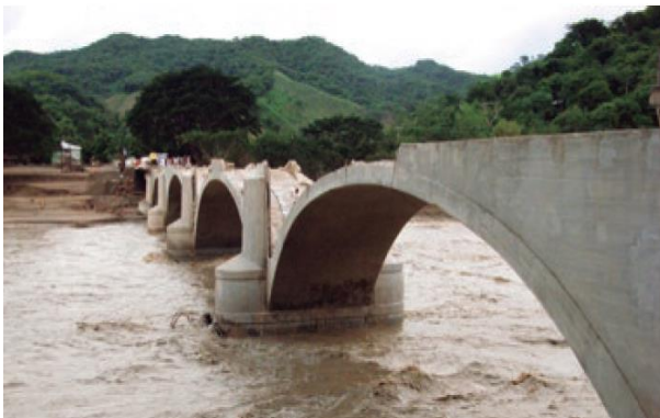
Figura 4.6 Destrucción de la superestructura del puente Papagayo
