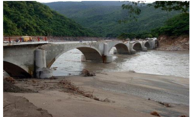
Figura 4.6 Destrucción de la superestructura del puente Papagayo
