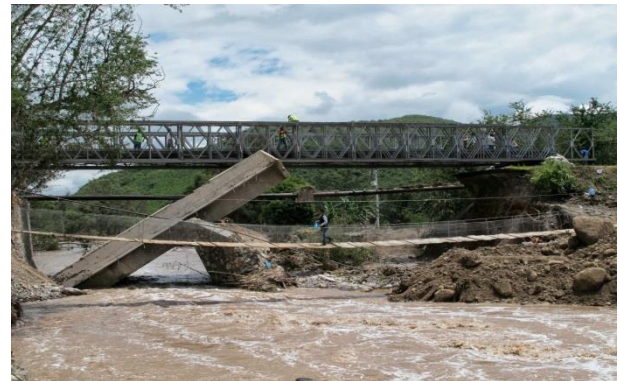
Figura 4.5 Colapso del puente Petaquillas
