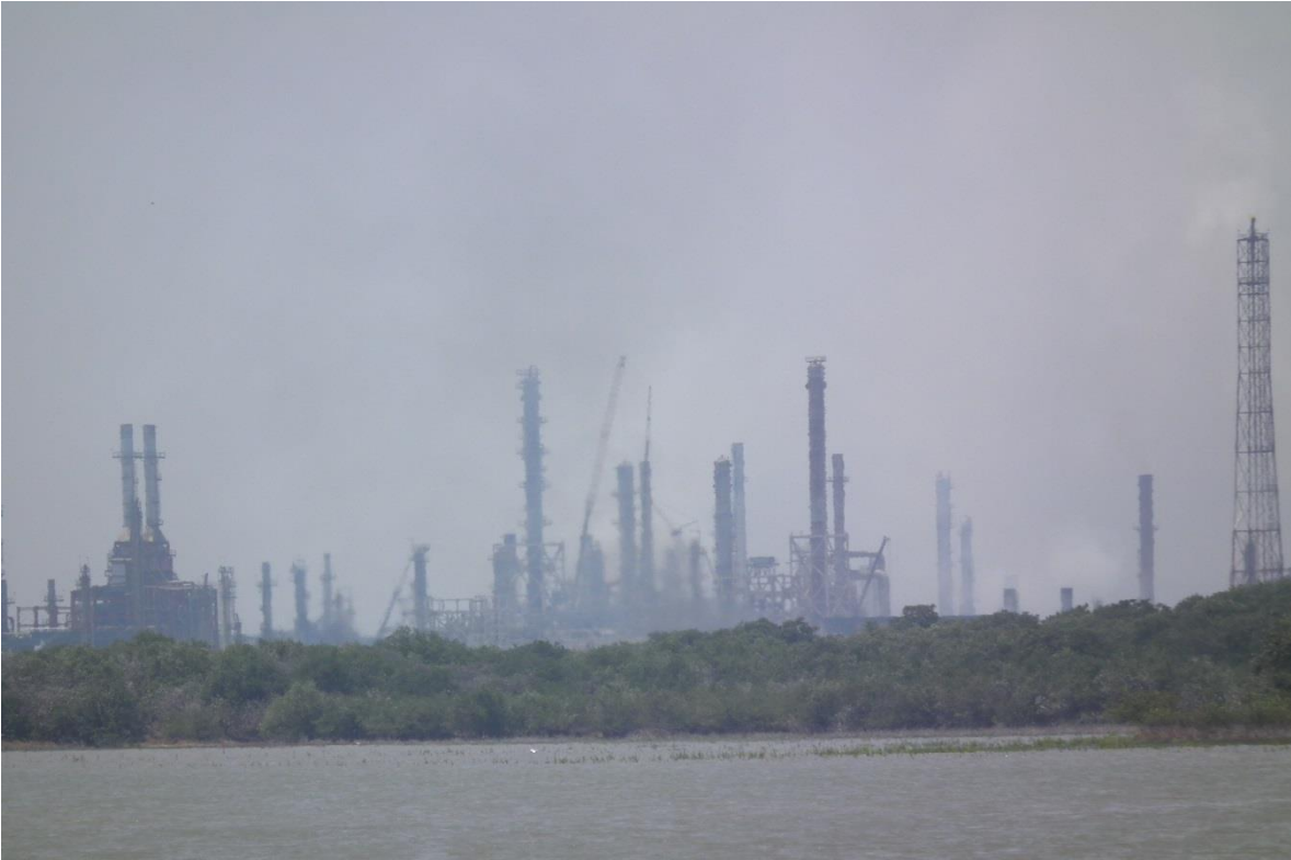
Bruma ocasionada por los gases de la refinera que se concentran sobre Estero La Ventosa.
