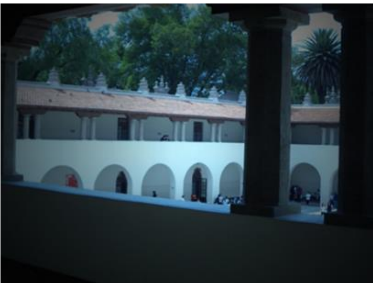
Patio remodelado de la escuela
