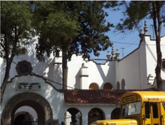
Fachada de la Primaria
