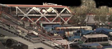
2 CETRAM Metro Constitución 1917
