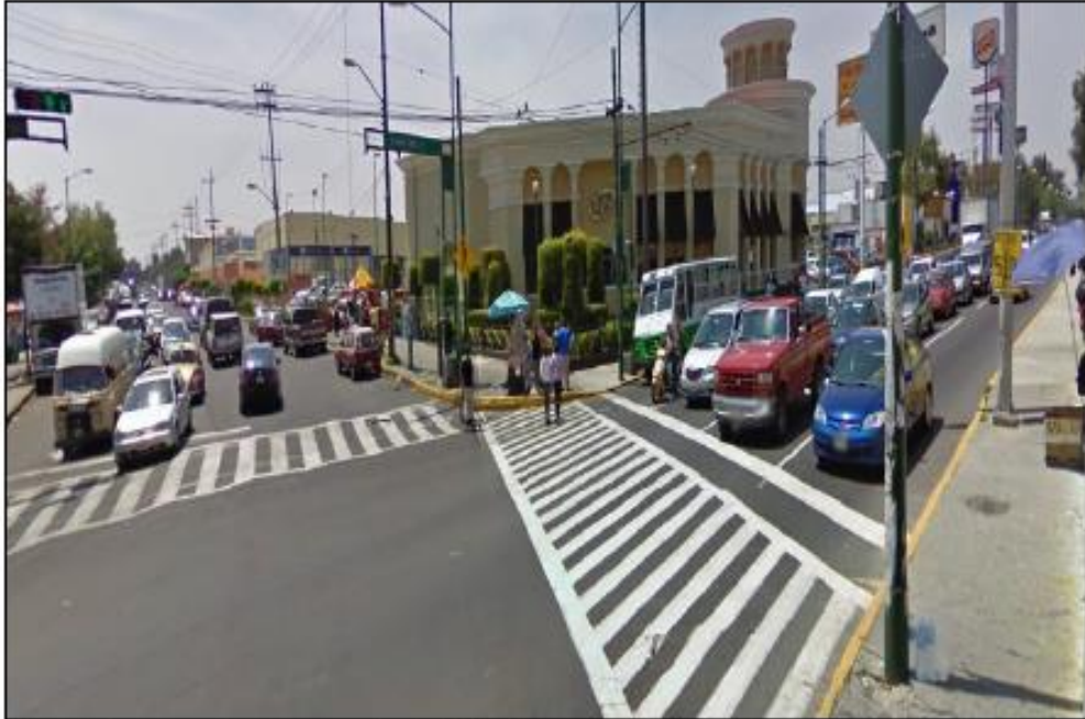
En esta imagen se observa que en la calle Oriente 157 no existe camellón que separe los sentidos sobre esta calle
