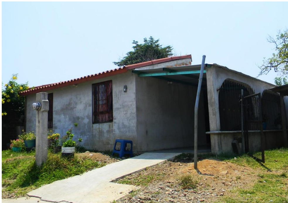
Ilustración 12: Vivienda con modificaciones: presenta corredor, colocación de recubrimiento y uso de lámina de zinc. Fuente: Propia
