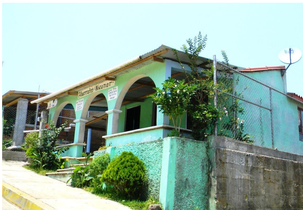
Ilustración 13: Vivienda con modificaciones: presenta corredor, acceso frontal, colocación de recubrimiento, color, uso comercial y de lámina de zinc. Fuente: Propia
