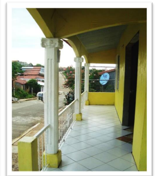
Ilustración 34. Modificación a la vivienda Corredor y columnas. Fuente: Propia
